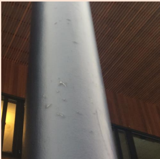
Bilde viser ulike partier av søyler nede, akse A/19-29. Brannmalingen har skader spredt over hele søylen. Til høyre: Toppstrøk flasket av den lys grå brannmalingen vises. Primer / mellomstrøk kan ses nederst.
