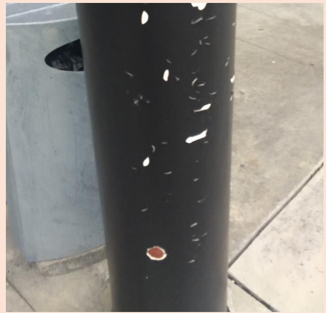
Bilde viser ulike partier av søyler nede, akse A/19-29. Brannmalingen har skader spredt over hele søylen. Til høyre: Toppstrøk flasket av den lys grå brannmalingen vises. Primer / mellomstrøk kan ses nederst.
