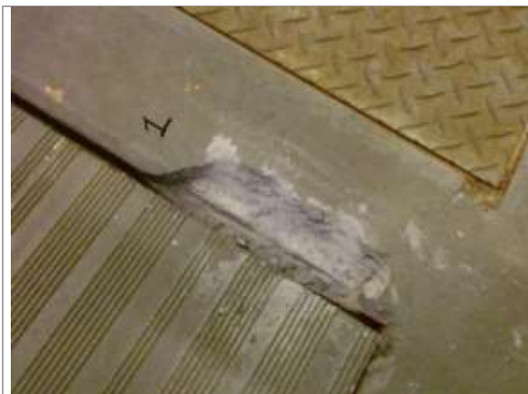
Bilde 5: Betongprøve fra bassengkanal.
