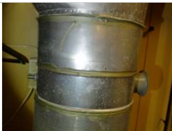
Bilde 4: Prøvetatt fugemasse i ventilasjonsanlegg.
