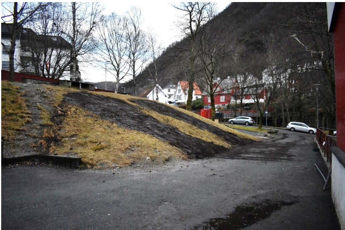
Figur 22. Sjakt 1 og 3 etter gjenfylling. Foto mot nordaust.
