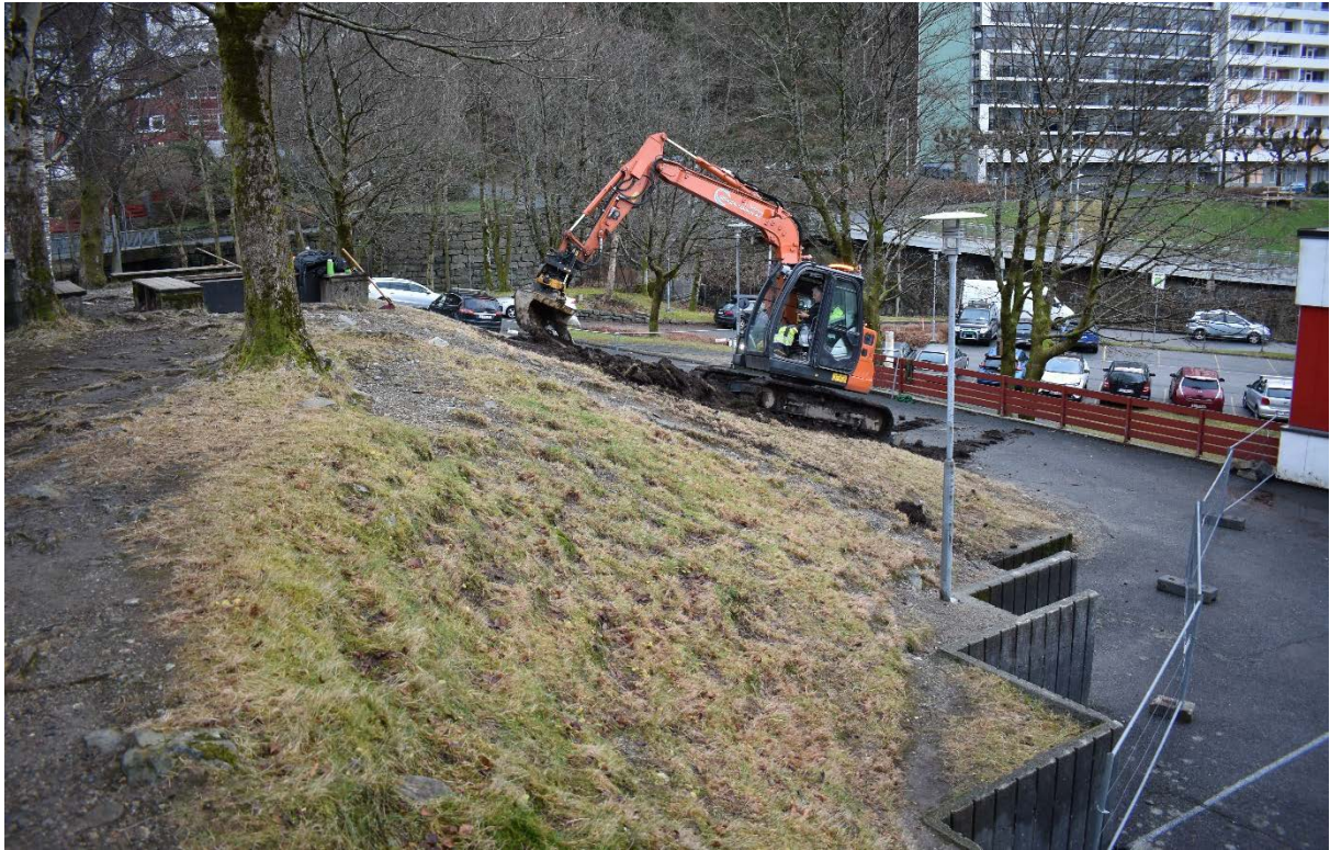
Figur 19. Oversiktsbilete, sjakt 1 under graving. Foto mot aust/søraust.
