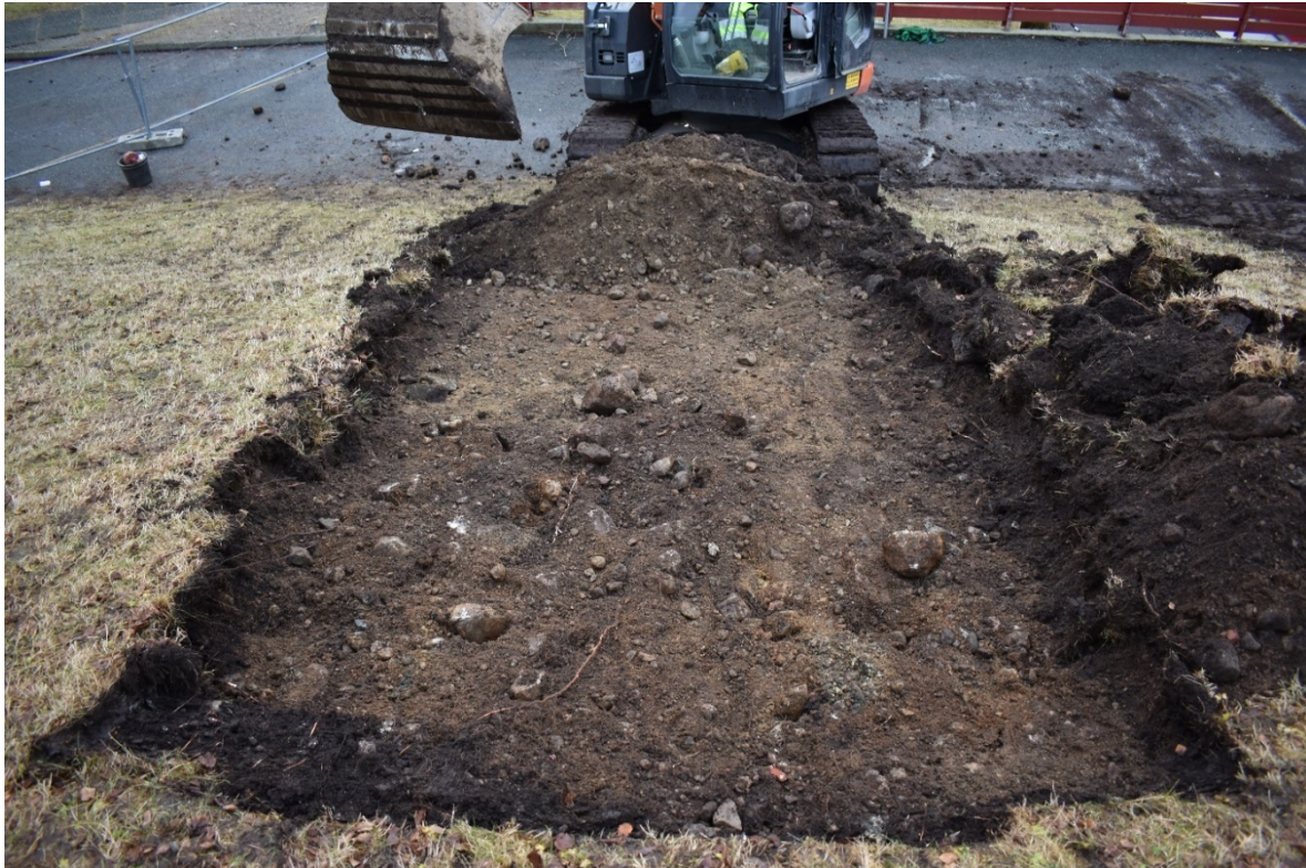
Figur 21. Sjakt 3 under graving. Foto mot sør.
