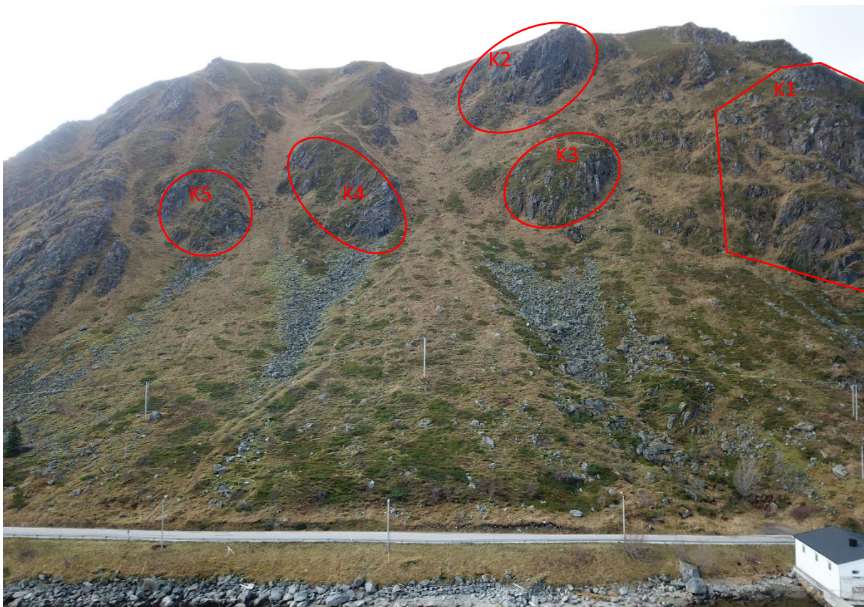
Figur 11: Dronebilde med de mest aktuelle kildeområdene for steinsprang grovt skissert i rødt. Bilde viser tydelige steinsprangavsetninger ovenfor og nedenfor veien.
