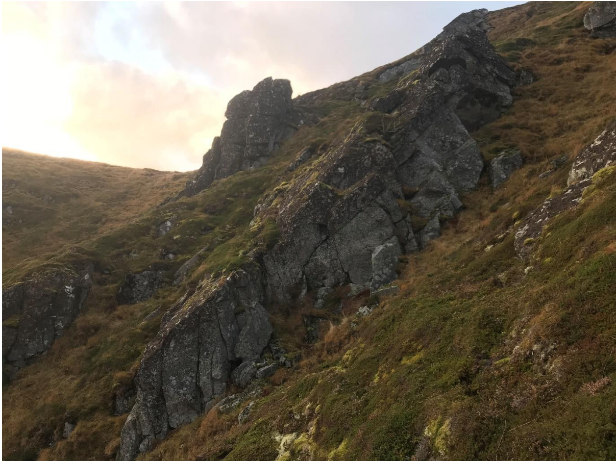
Figur 15: Bilde av berghammeren der det er aktuelt med arbeidssikring ovenfor støtteforebygning B6.
