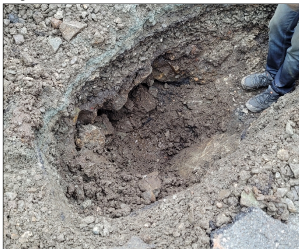
Figur 3: Bildet av gravd sjakt i Morvikveien 80 i Bergen kommune.
