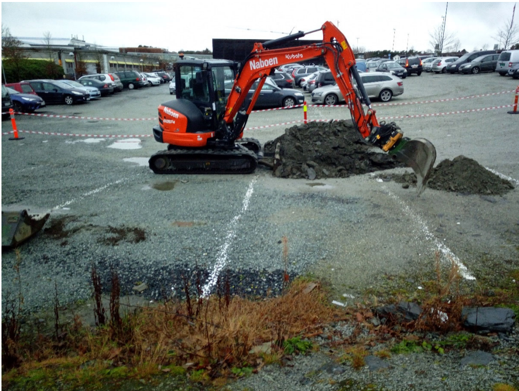
Bilde B1. 6 tonn gravemaskin av fabrikat Kubota KX057-4 brukt til arbeidene.
