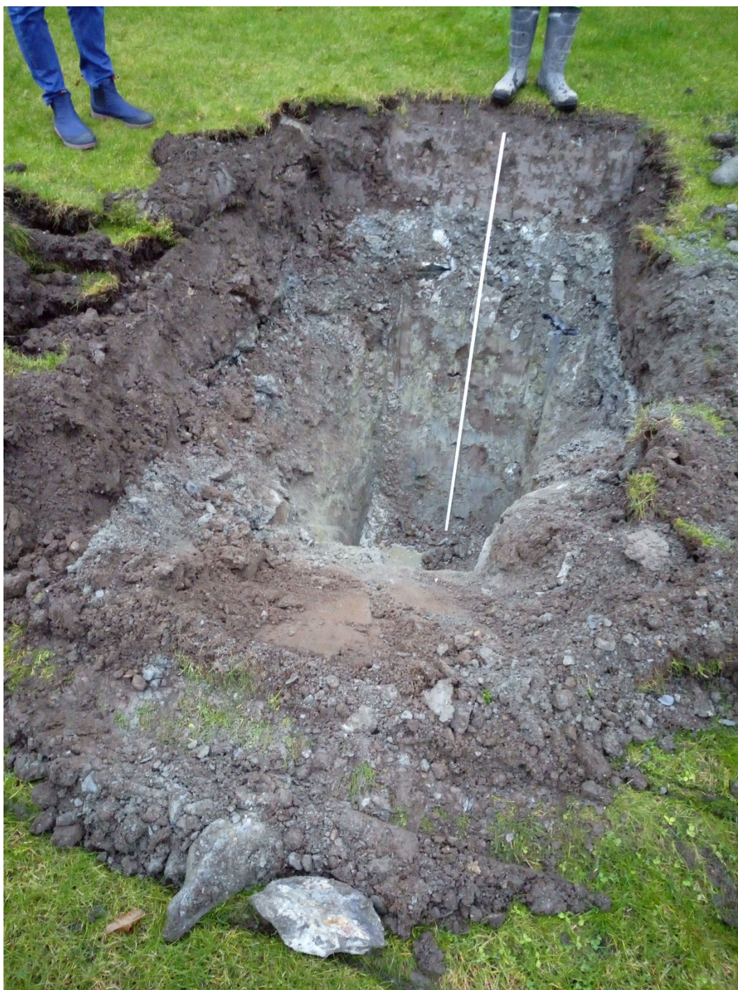
Bilde B5. Prøvegrop P2. Ca. 2m graving til berg.
