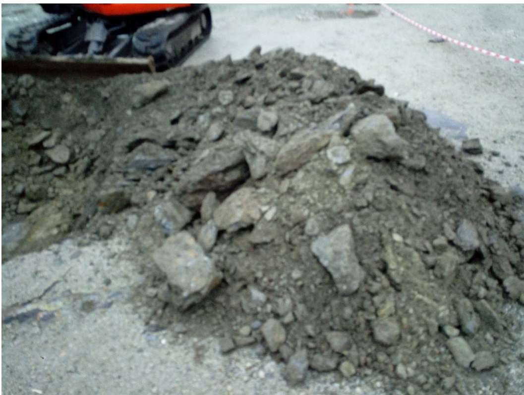
Bilde B4. Fyllmasser prøvegropp P1. Fyllmasser av stein med forskjellige størrelse.
