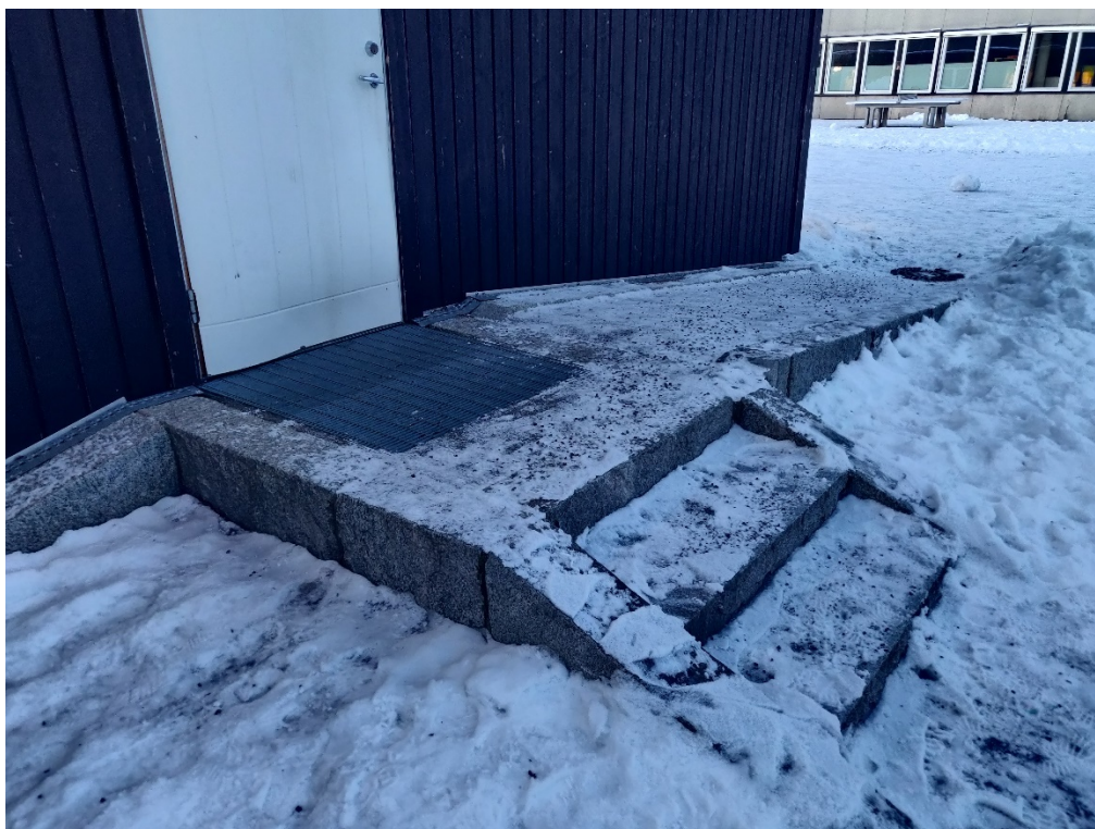
Granittsteiner og rist demonteres og tas vare på
