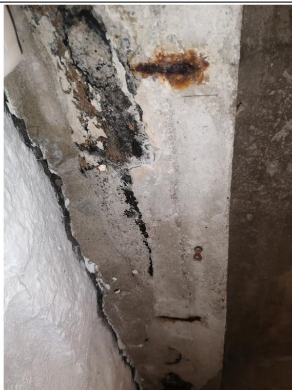
10: Bjelke mot bygningsfasaden, bod innvendig
