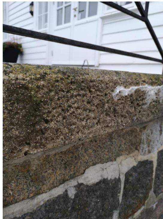
4: Dekkeforkant mot sør
