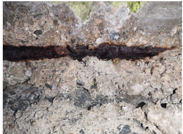
8: Korrodert glattstål
