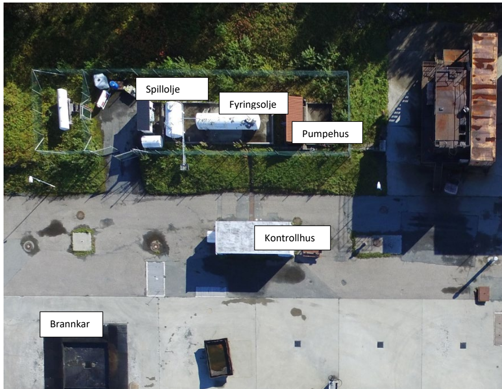
Figur 2-7: Foto av anlegget slik det ser ut i dag.
