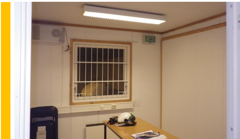
Figur 6-8 Nyere isolerglassruter i Bygg 20.
