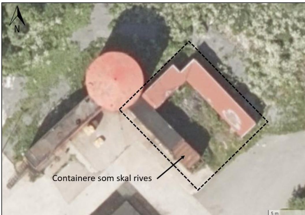
Figur 5-13 Bygg 28, containeranlegg. Det er ikke påtruffet farlig avfall, bygget er av metall. Det tatt betongprøve fra gulv i bygningen, se kapittel 0.
