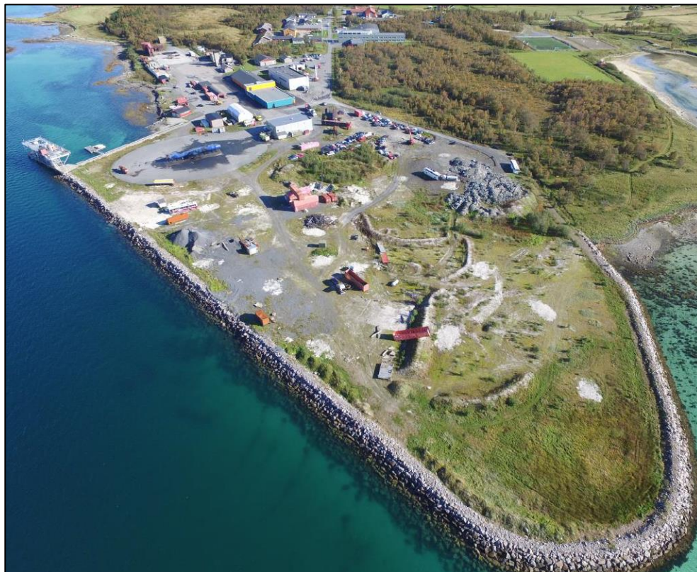
Figur 2-3 Oversiktsbilde av tiltaksområdet.
