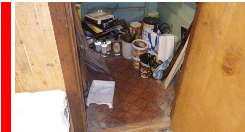
Figur 6-11 Gulvbelegg av vinyl i et av de to smårommene i Bygg 35.
