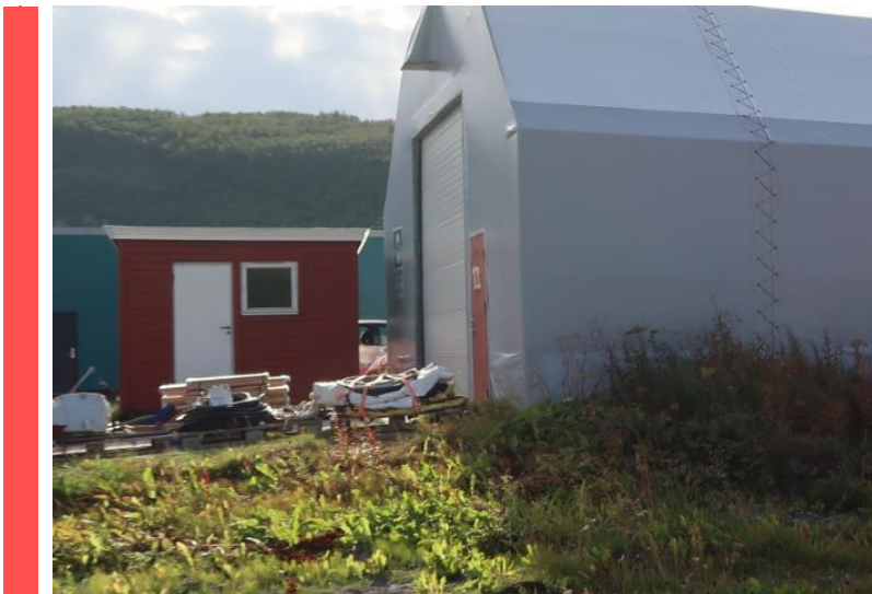
Figur 6-5 Umerket isolerglassvindu med mistenkt innhold av PCB i brakka ved plashallen Bygg 16.
