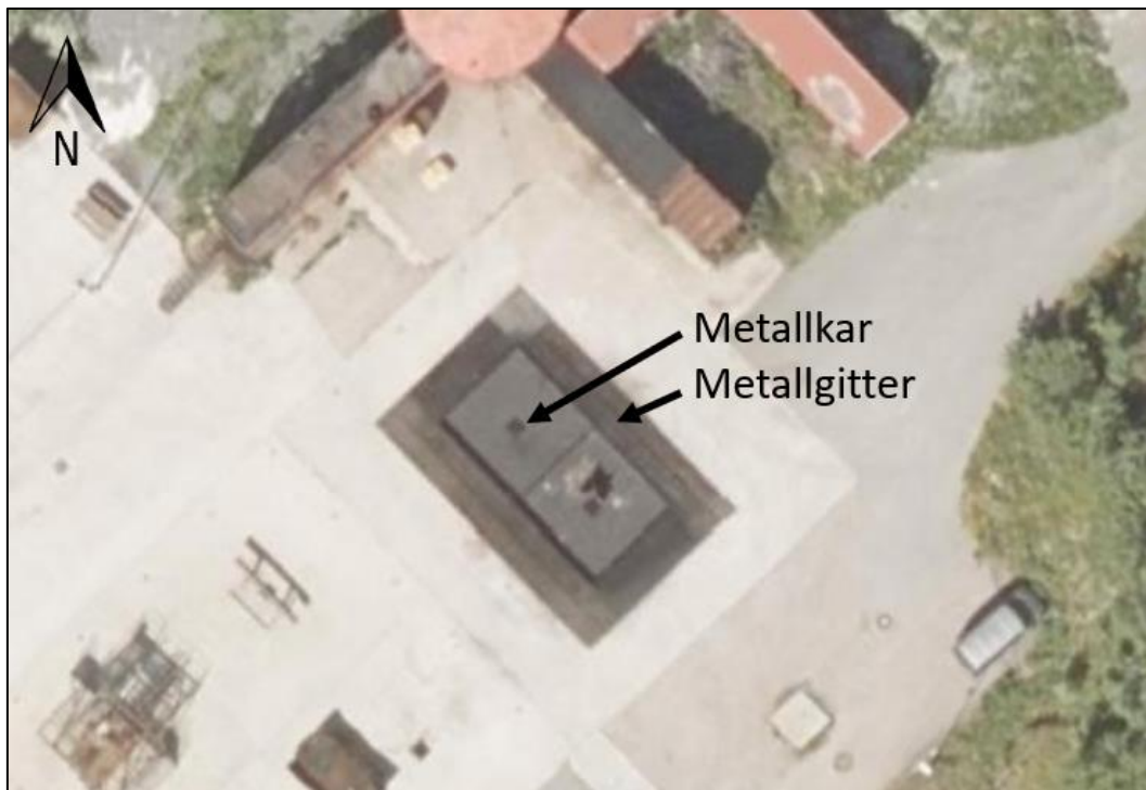
Figur 5-19 Objekt 79a, brannkar. Brannkar og området rundt det består av metall. Det er ikke samlet inn prøver fra ledninger under brannkaret. Ledningene antas å inneholde olje.
