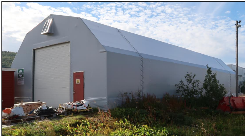
Figur 6-9 Bygg 16 her helt dekket i plastduk.
