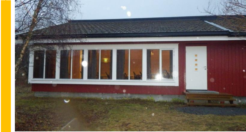
Figur 6-7 Nyere isolerglassruter i Bygg 6.
