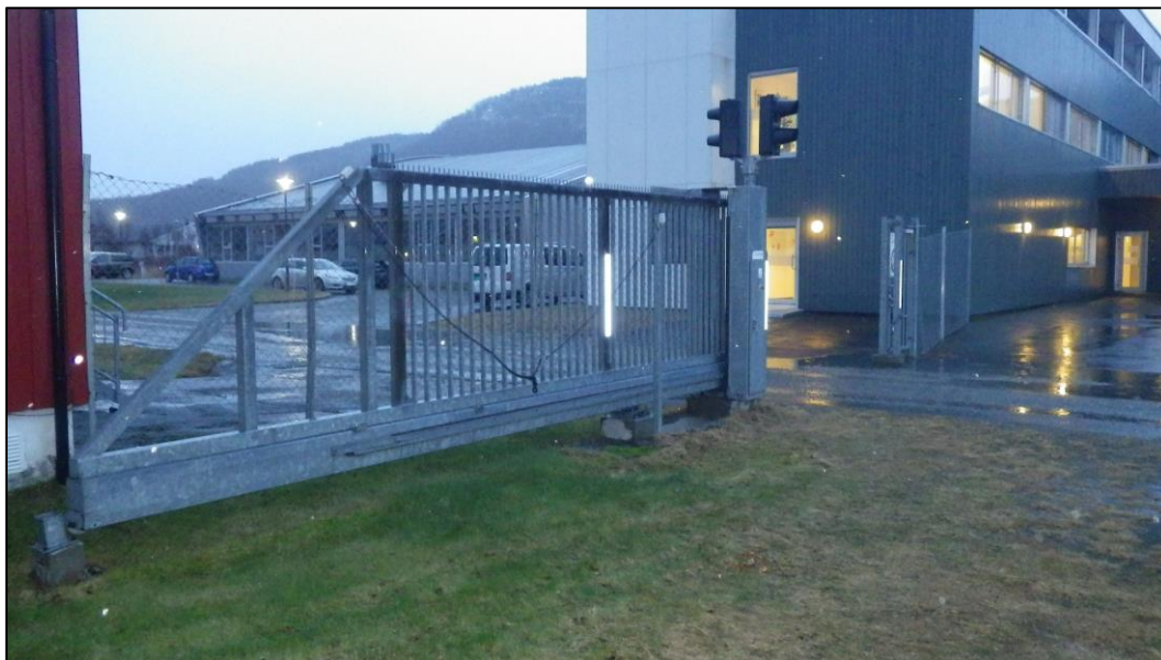
Figur 5-17 Konstruksjon 54, hovedport. Inneholder elektrisk motor og trafikklys som er EE-avfall.
