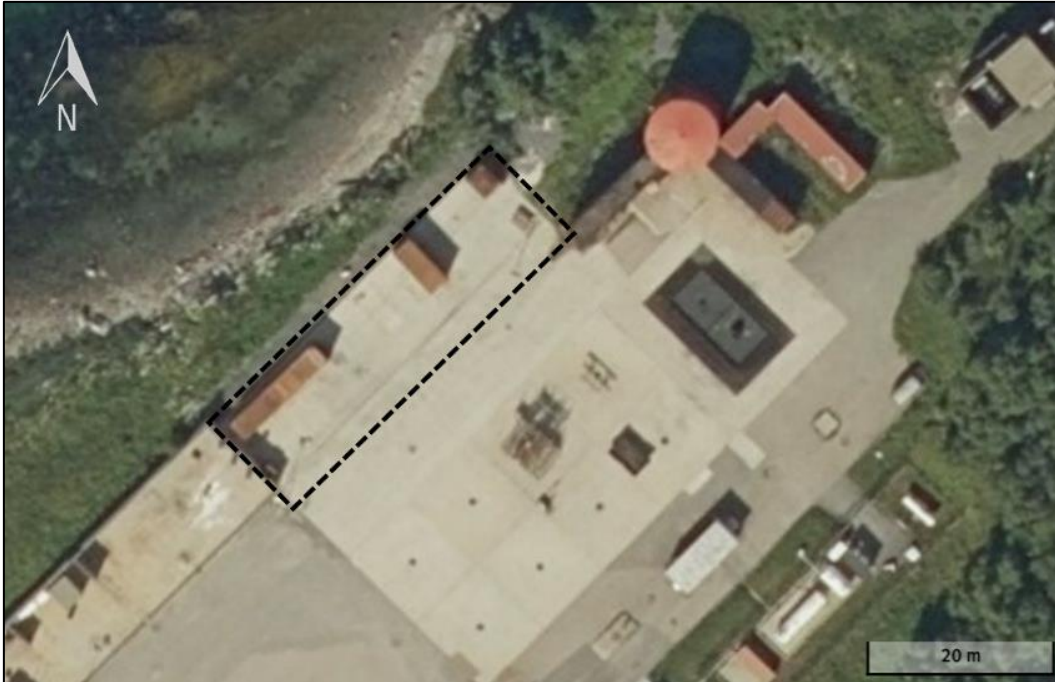
Figur 5-12 Område 27. Containerne står løst på betongdekket, og er ikke plassert som på bildet. Fire stålcontainere var plassert innenfor området ved befaringen. Det var sterk bensinlukt i én av containerne, men det er ikke påtruffet farlig avfall. Betonggulv antas forurenset.
