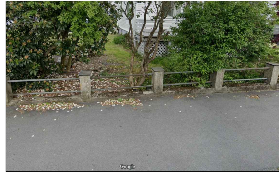
Bilde av murkant ved Kannikgata 37C
