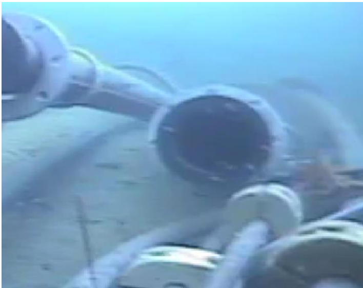
Figur 2 Enden av dagens overløpsledning
