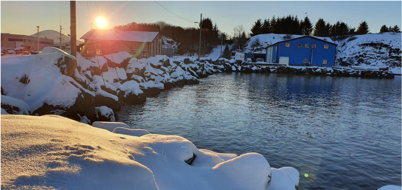
Figur 6: Bilde av molo tatt mot sørvest på miljøbefaring 14.01.21
