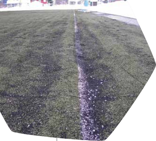
Kjøring på banen med for tungt utstyr under teledøsningen
