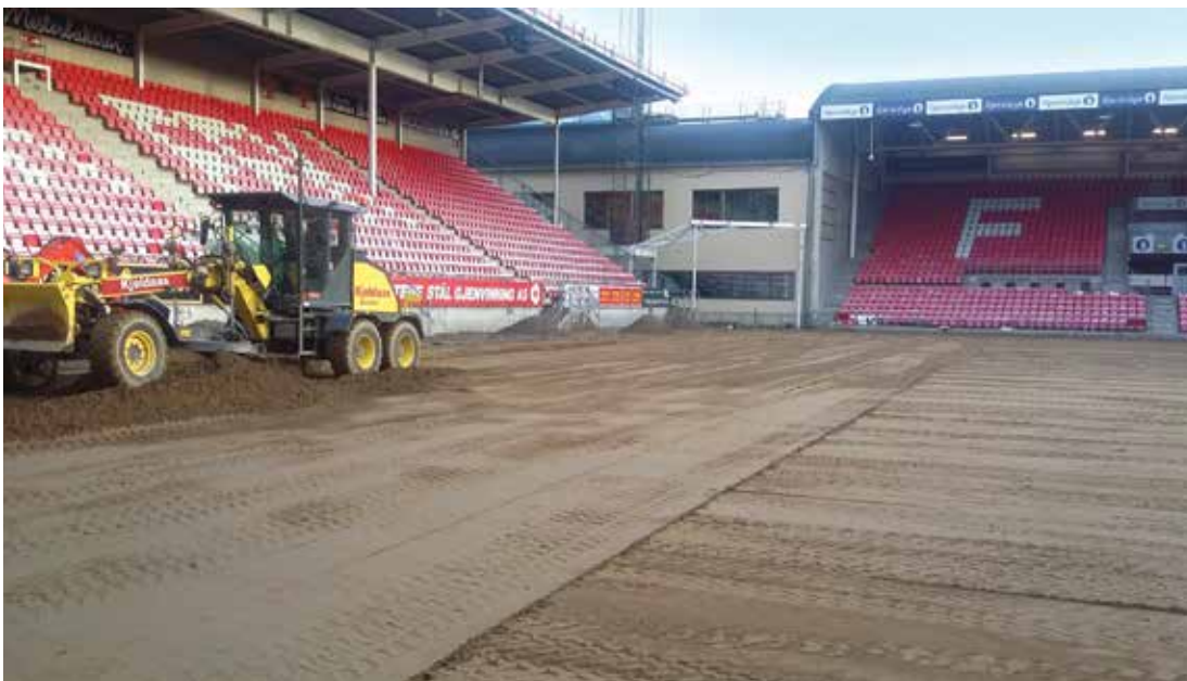
Avretting av topplag på Fredrikstad stadion
