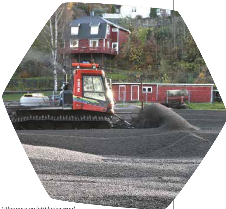
Utlegging av lettklinker med prepareringsmaskin
