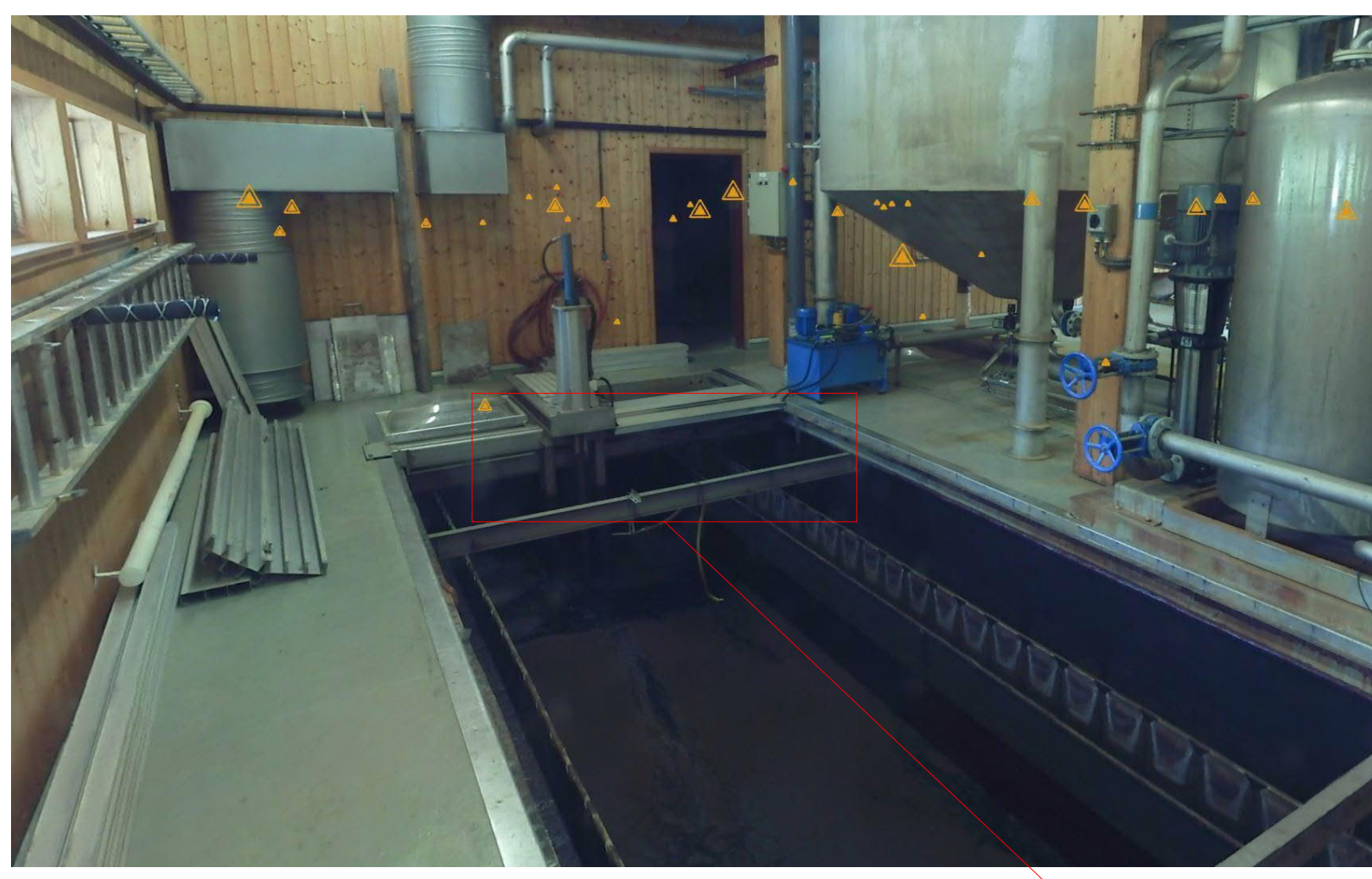
Skjære åpning i utløpskanalvegg
