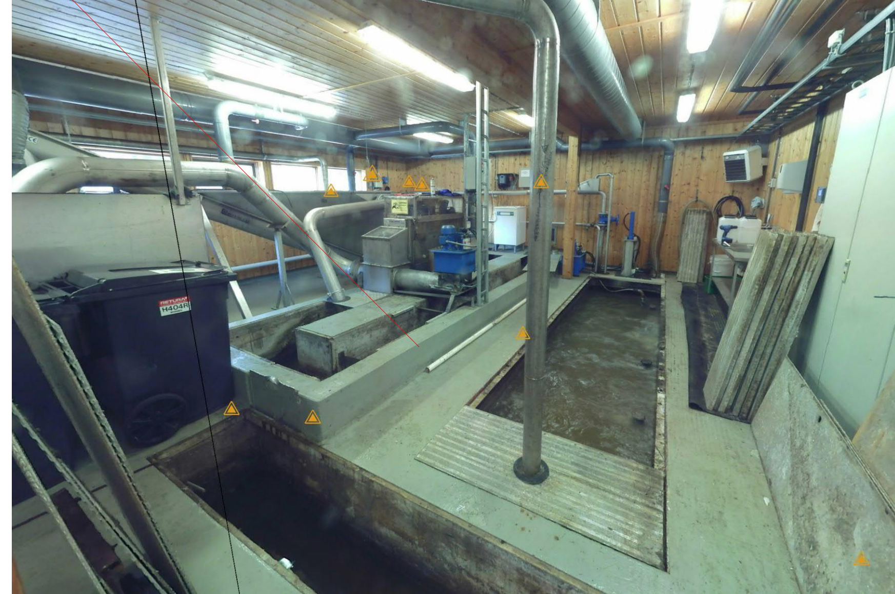
Sokkel/fundamenter pigges og rives i nytt septikmottak
