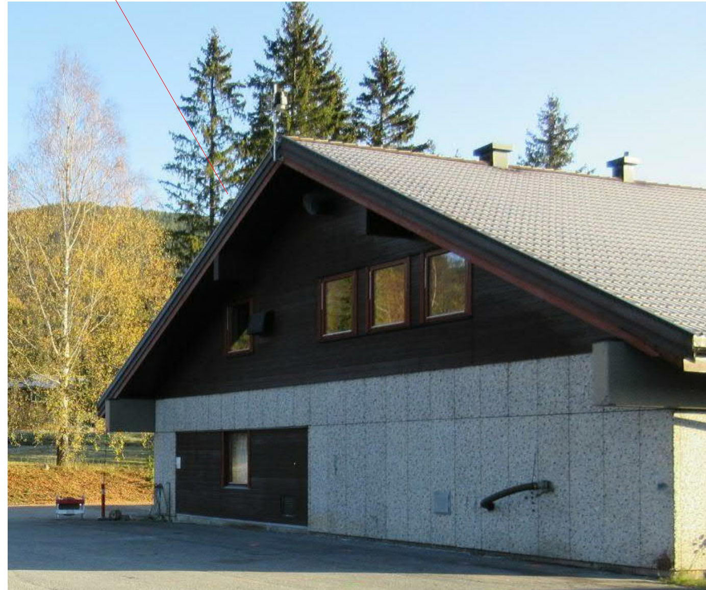
Eksisterende gavvegg mot vest - ytterkledning og vinduer skal fjernes.
