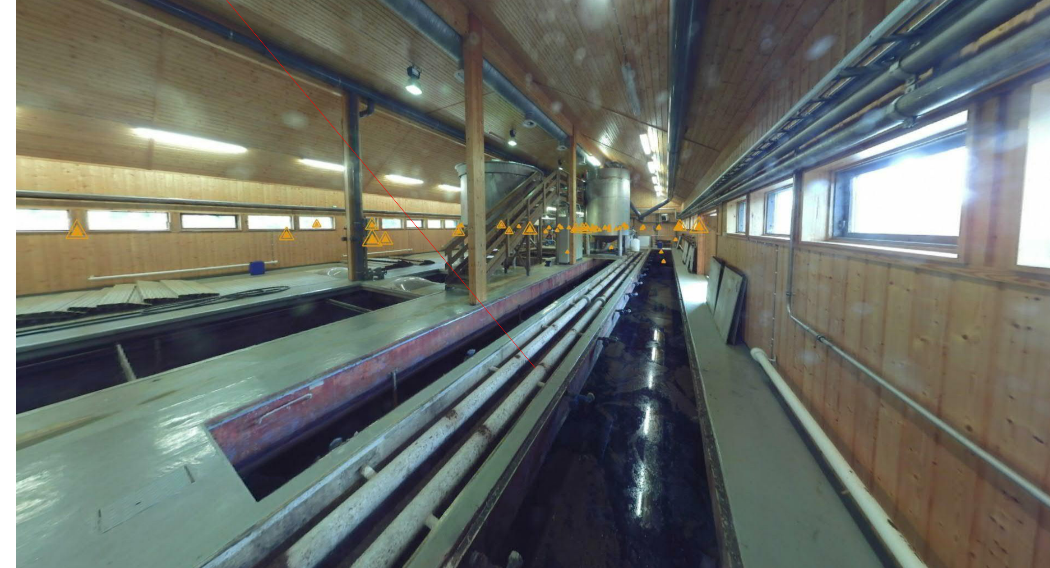
Bassengvegg med kanal i OK fjernes
