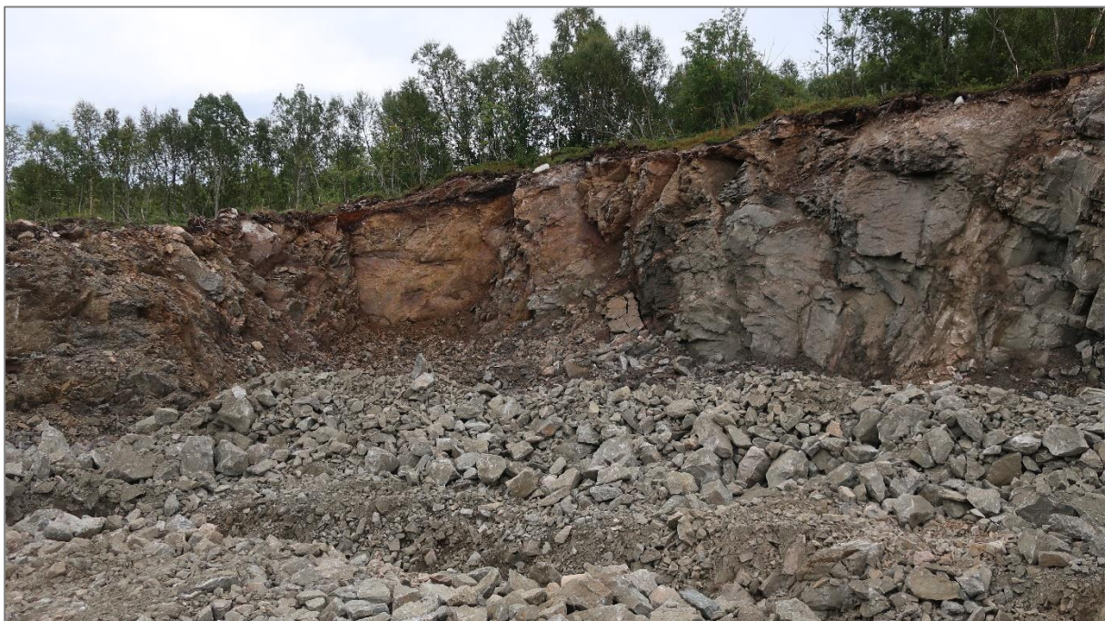
Figur 6: Eksisterende skjæring lengst øst i planlagt tomt, sett mot sør. Herfra skal det sprenges videre innover i terrenget.
