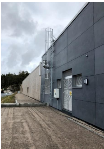
Figur 4– bygg 5 m/ leder på baksiden.
