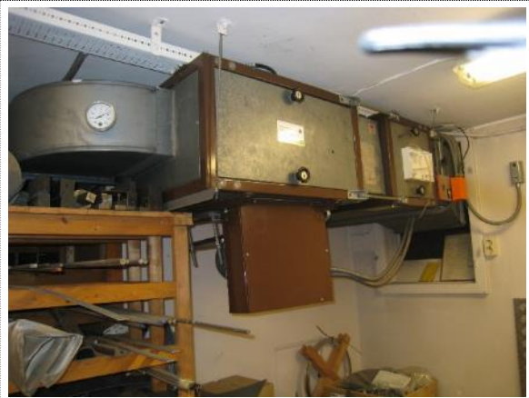
Bilde nr. RIV 33 Aggregat for versksted er utgått på dato
