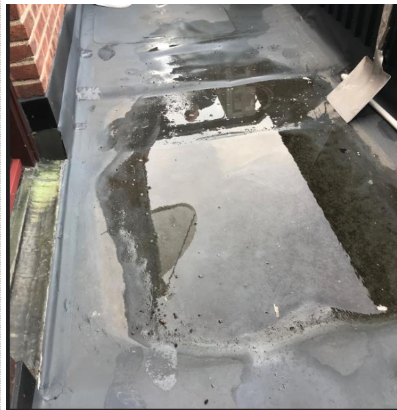
Bilde nr. RIB 01 Stående vann på takflate uten fall mot sluk.
