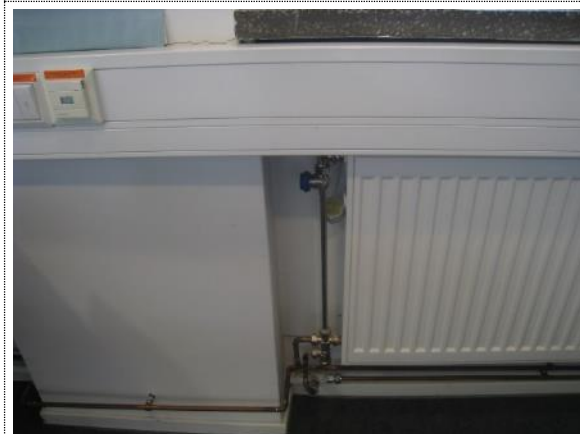
Bilde nr. RIV 08 Det er brukt kobber rør i varmeanlegg. Ikke iht varmenormen.
