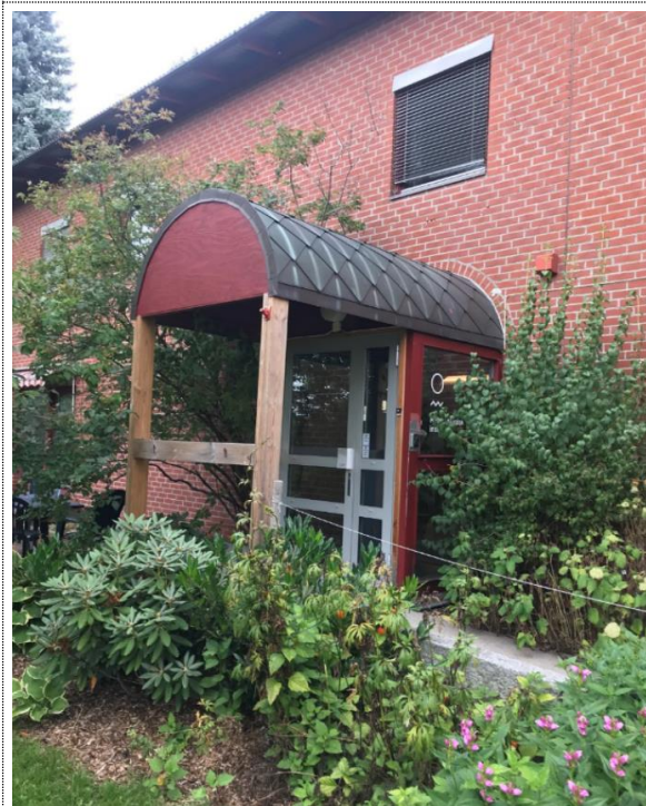
Bilde nr. RIB 38 Vindfang/inngangspartiet til avlastningsbygget.
