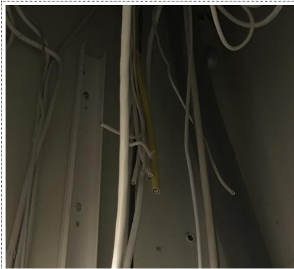
Bilde nr. RIE33 Kabler som er klippet uten å bli terminert i henhold til regelverk.
