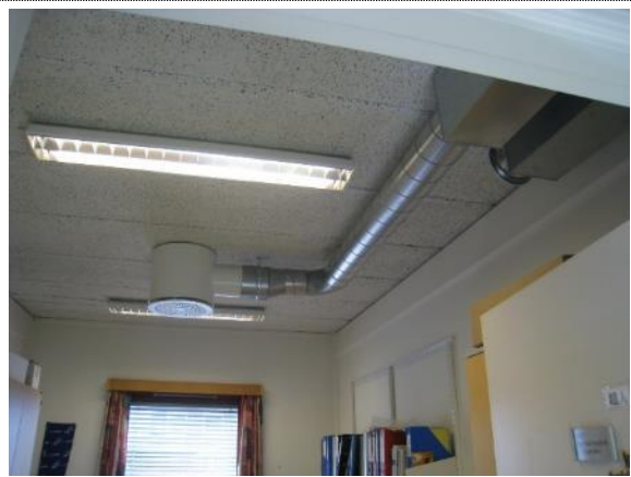
Bilde nr. RIV 47 Ventilasjonsløsning i typisk kontor. Ingen romstyring
