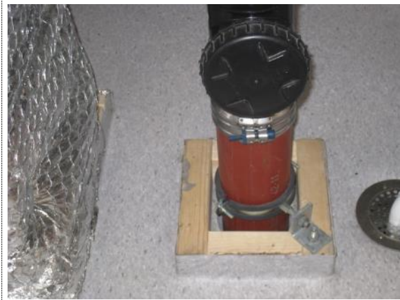
Bilde nr. RIV 52 Opplegg, gjennomføring i dekke i MA. OK
