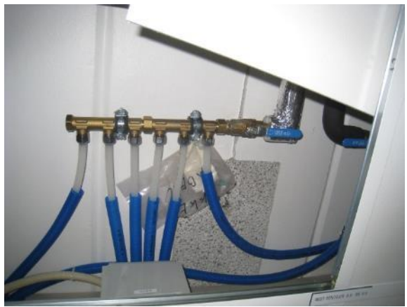
Bilde nr. RIV 51 Rørfordeler i tak korridor. Ikke helt vannskade sikker løsning.
