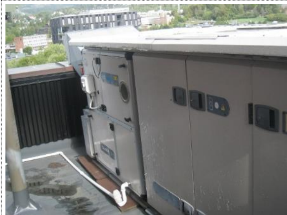
Bilde nr. RIV 04 Gold aggregat på tak for værsal
