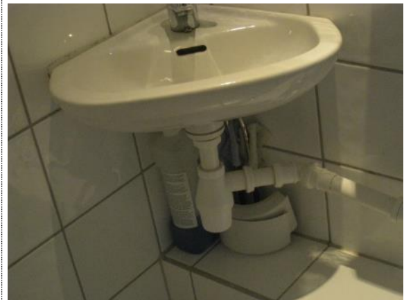
Bilde nr. RIV 02 Rør innstøpt i vegg
