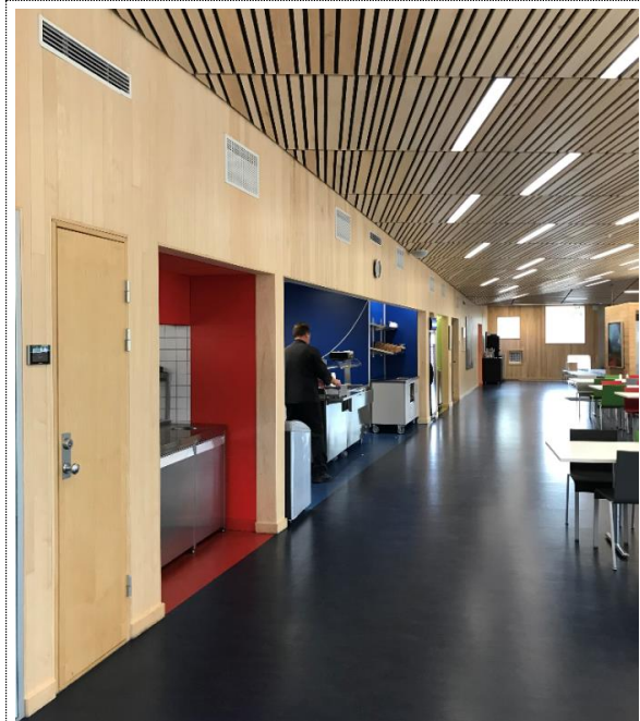
Bilde nr. RIB 22 Kantineområdet med utvekslede åpninger med stålforsterkning.
