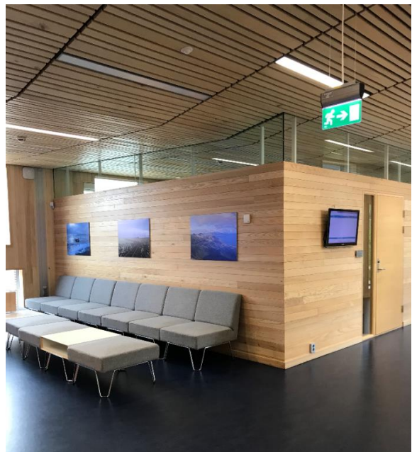
Bilde nr. RIB 23 Møteromsvegger med glassfelt.
