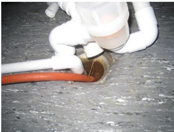
Bilde nr. RIV 13 Belegg/sluk virker dårlig tilpasset.
