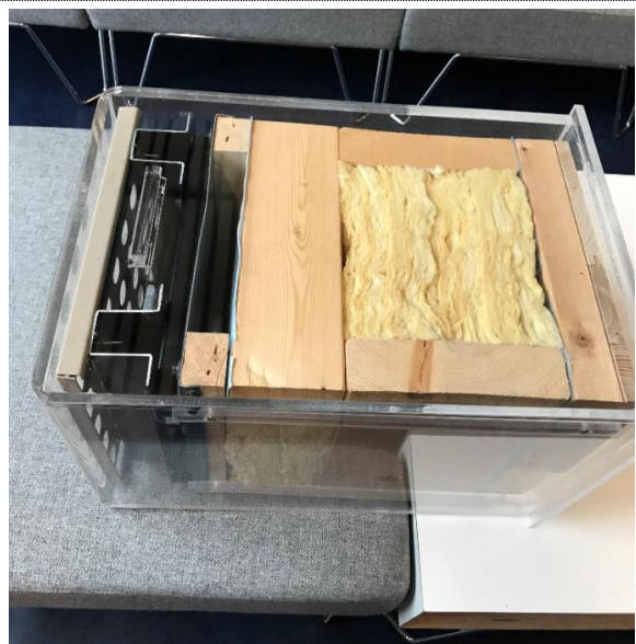
Bilde nr. RIB 21 Prinsipiell oppbygging av yttervegg.
