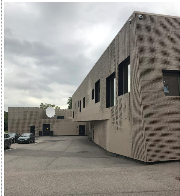
Bilde nr. RIB 24 Fasade med perforerte eller delvis perforerte plater i aluminium.
