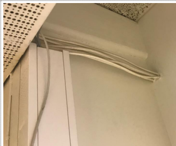
Bilde nr. RIE33 Kabler som er klippet uten å bli terminert i henhold til regelverk.
