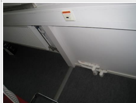
Bilde nr. RIV 08 Det er brukt kobber rør i varmeanlegg. Ikke iht varmenormen.
