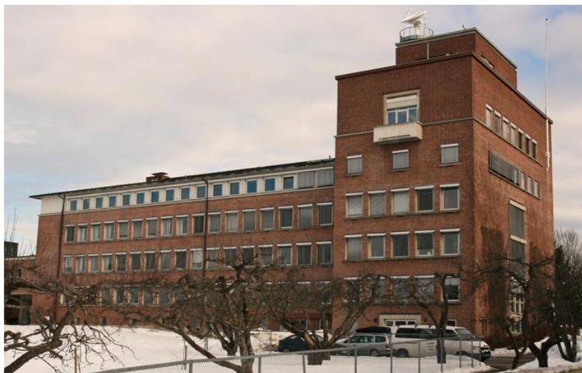
Figur 3.10 Hovedbygg- oppført 1940 Foto: Statsbygg
