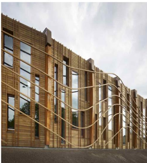
Rijkswaterstaat Assen. Arkitekt: 24H Architecture. foto: Christian Richters. kilde: www.archdaily.com
