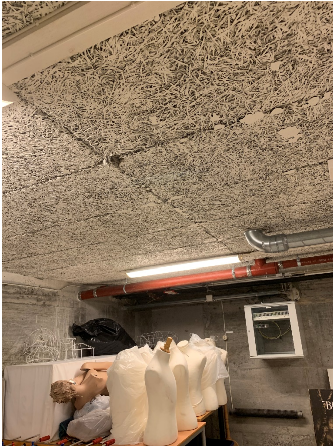
Bilde 11: Treullplater i himling i lager kjeller
