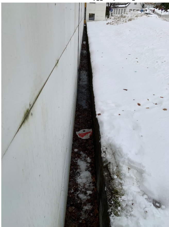
Bilde 15: Betong støttemur langs nordfasade
