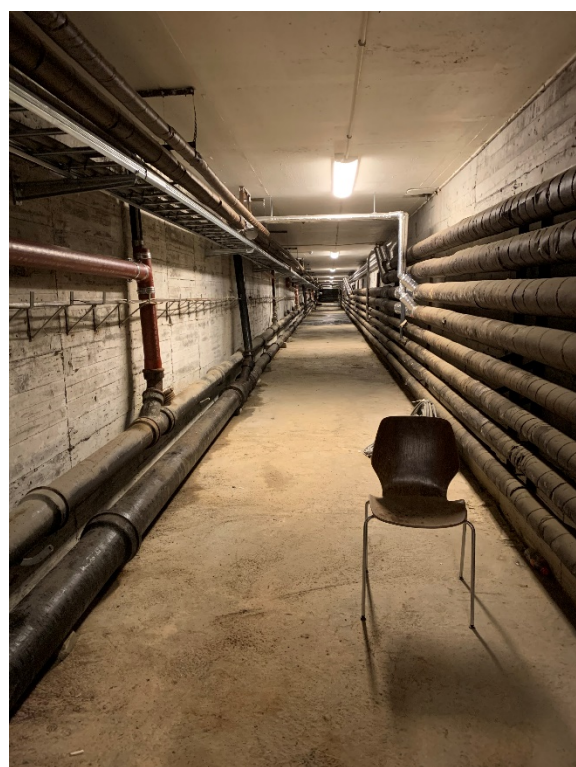
Bilde 13: Kulvert i kjeller
