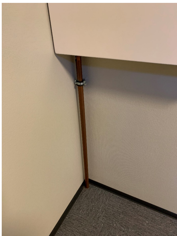
Bilde 10: Kobber vannrør fra brannslangeskap i korridor
