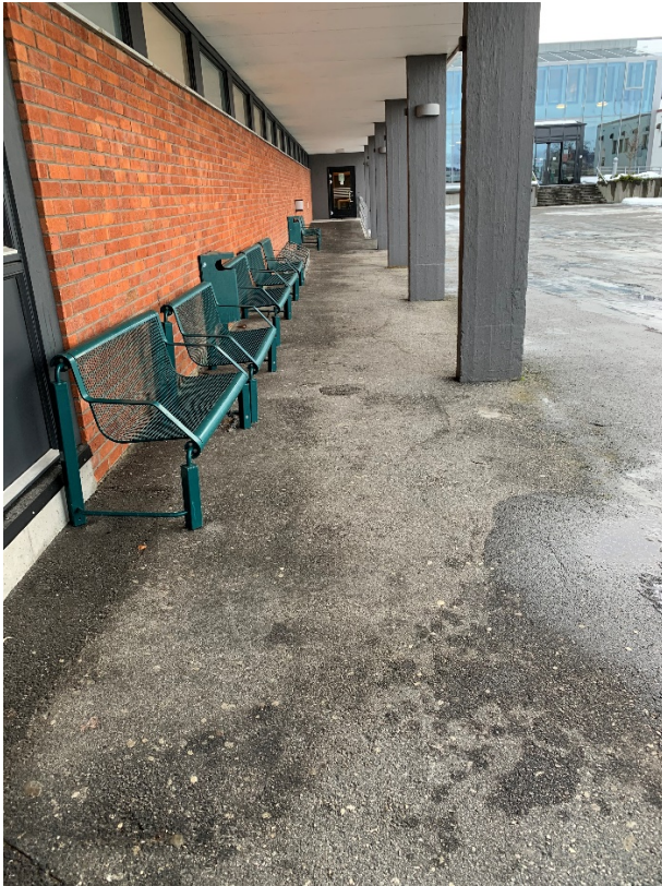
Bilde 1: Asfalt på bakken, hvor tilbygg skal etableres
