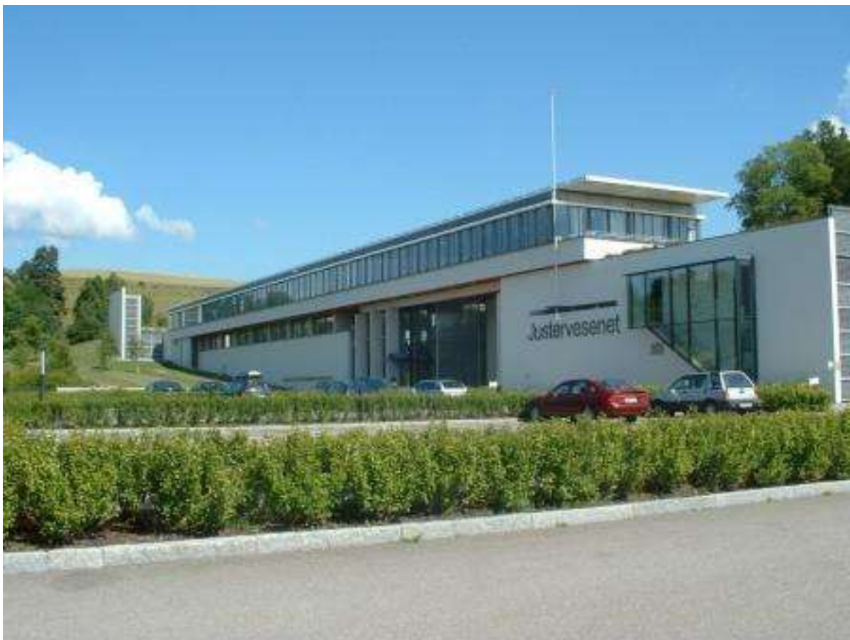
Figur 2.1. Fasade mot vest som skal rehabiliteres.
