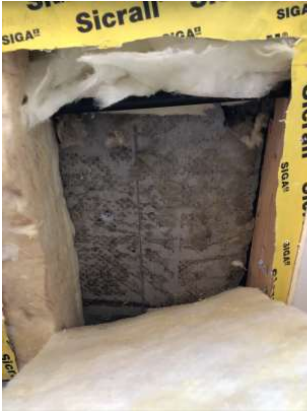
Figur 5.2. Veggen under et av vinduene i kantinen ble åpnet opp og det ble tatt ut en prøve av vindsperre. Veggene består av gips. Det er også radiatoranlegg her som skal skiftes ut.
