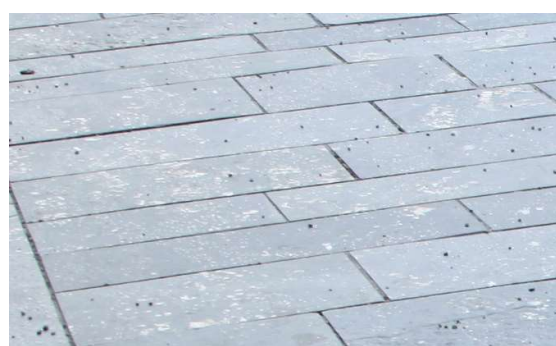
Skifersteinsdekke etter utskifting.
