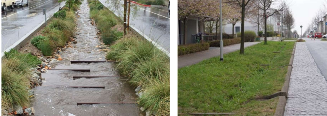
Figur 5: Flomsikringstiltak som kan gjøres i etterkant med dagens tverrsnitt. Foto: Orbicon og SVR Design Company, Seattle.
