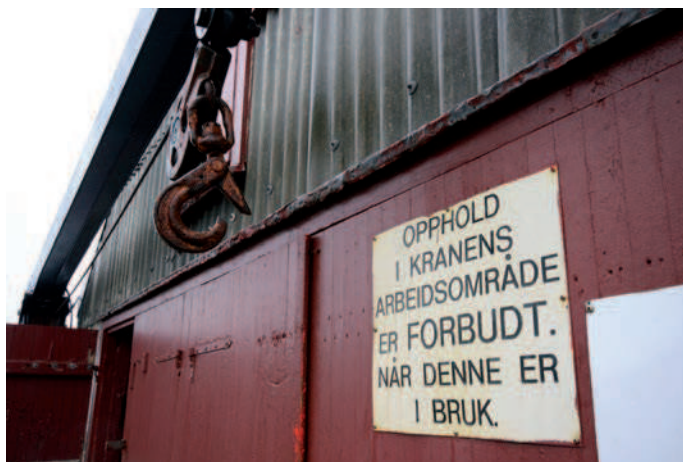
Fasade mot landing. Alle foto: Kystverket 6.5.2013.
