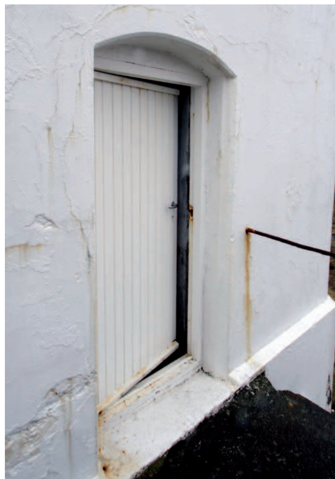
Til høyre: Inngangsdør mot øst.
