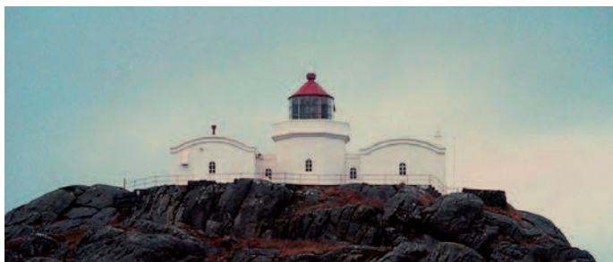
Geitungen fyrstasjon, Rogaland. Foto: Kystverket.
