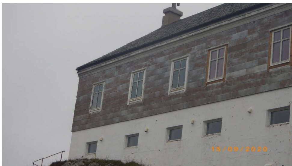
Bilde nr 4 – Vestre del av søndre fasade
