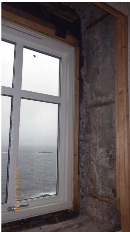
Bilde nr 10 – Innvendig i bolig-nytt vindu
