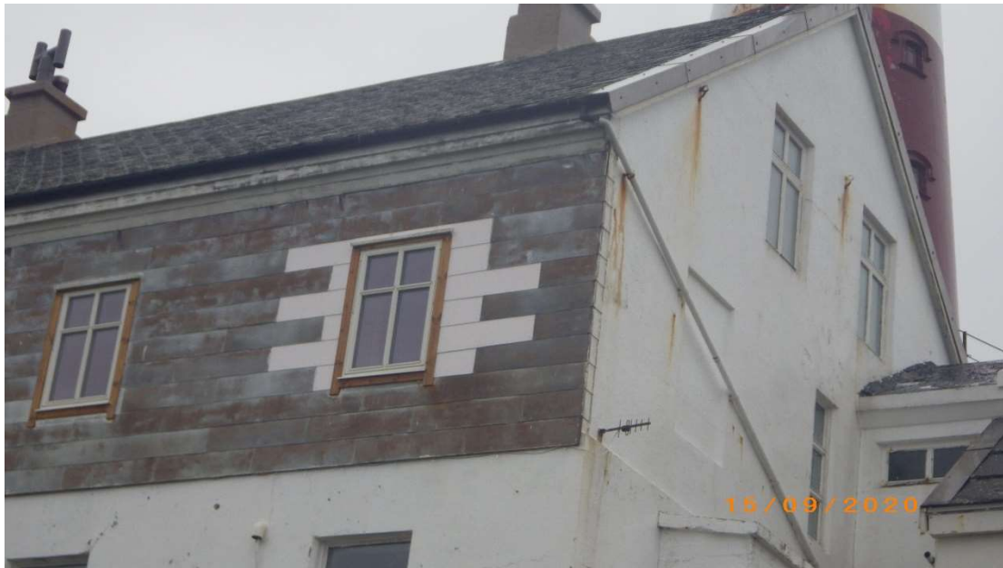
Bilde nr 5 – Østre del av søndre fasade
