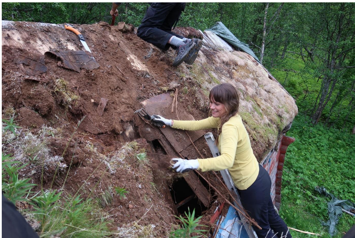
Stort hull i taket rett over inngangsdøra:
