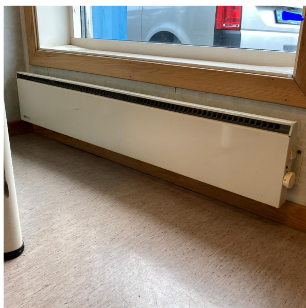
Bilde B2: Vinylgulvbelegg inneholder trolig ftalat og skal håndteres som ftalatholdig avfall.
