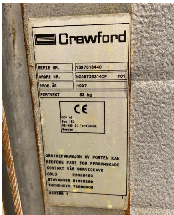
Bilde B3: Porter fra 1997, kan inneholde KFK/HKFK
