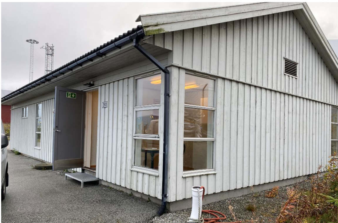
Figur 2: Fasadebilde av renseanlegget
