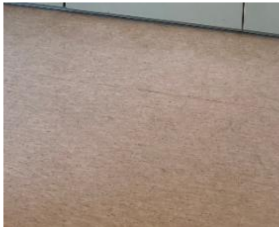
Bilde B2: Vinylgulvbelegg inneholder trolig ftalat og skal håndteres som ftalatholdig avfall.
