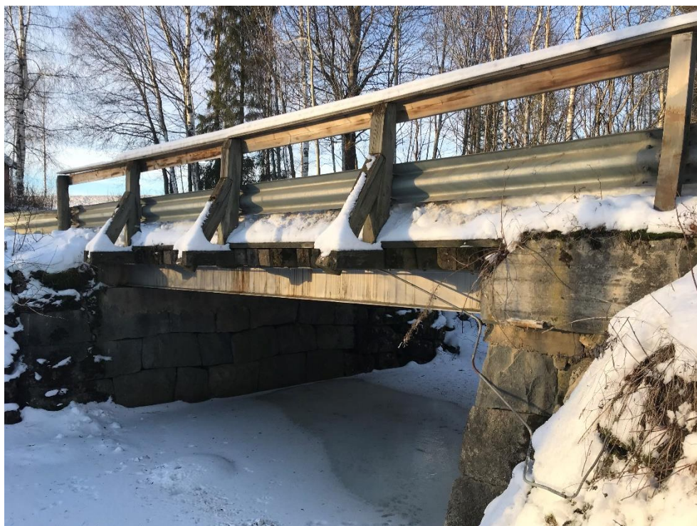
Figur 1: Rabstad bru, bilde tatt på befaringstidspunkt.
