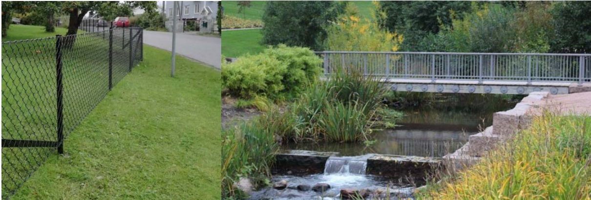
Figur 3-13: Bilde t.v. illustrer flettverksgjerde uten overligger. Kilde: allsikring.no Bildet t.h. illustrerer klatresikkert rekkverk på bro. Kilde: Groruddalen.no
