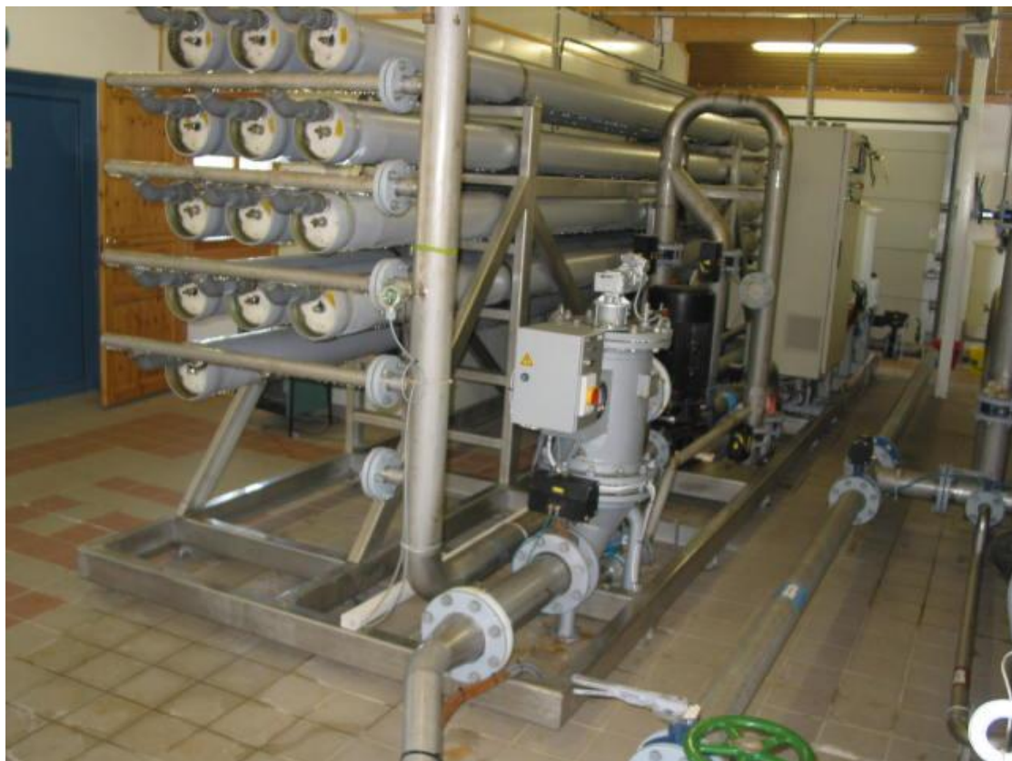
Membranrigg Dolmøy (kun 13 rør montert når bildet ble tatt)
