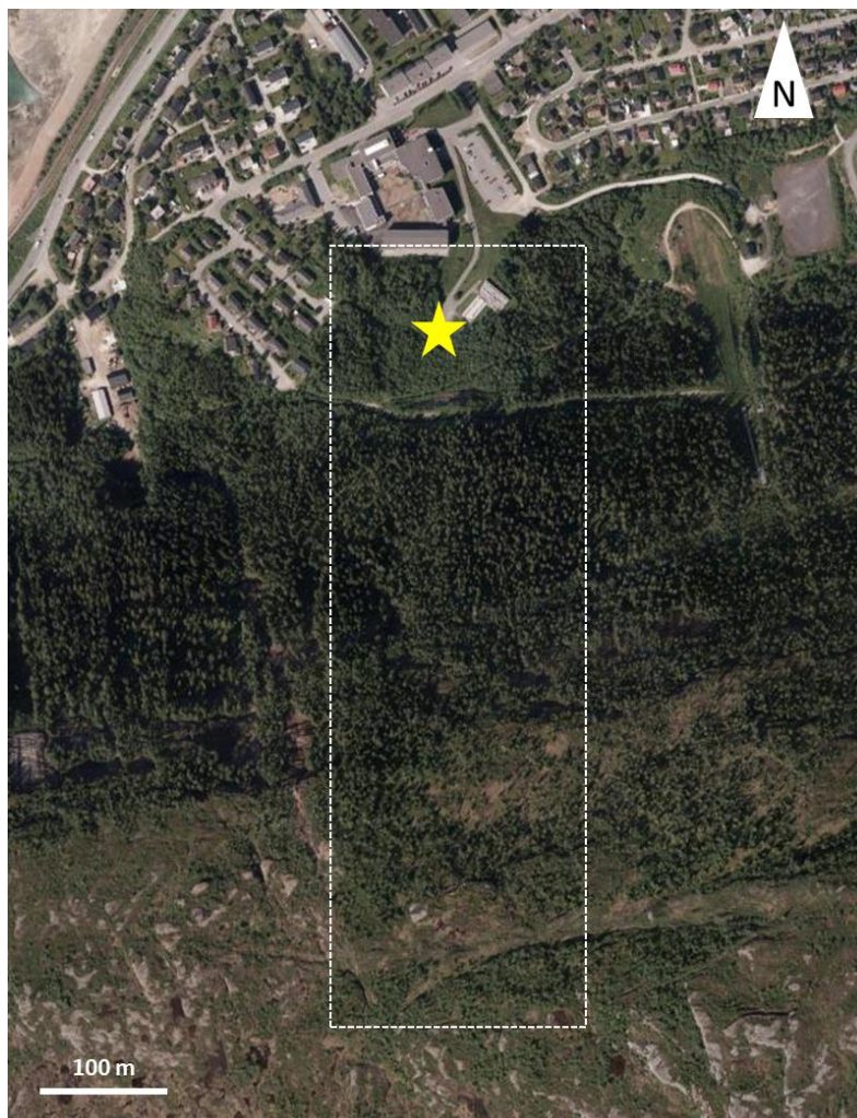
Figur 2. Flyfoto med oversikt over vurdert skråning (stiplet linje), samt ca. plassering av inngangsbygget (stjerne).
