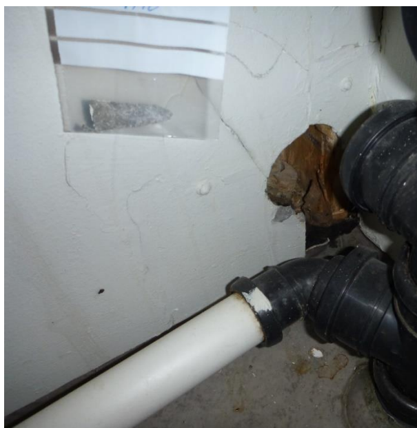
Rom D119. Asbestholdig plate på vegg.
