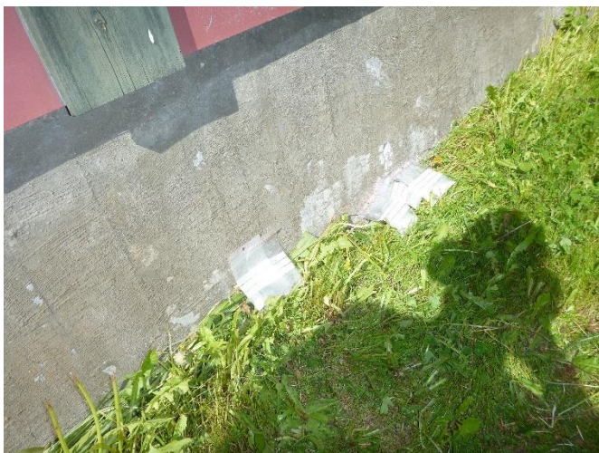
Betongprøver av utvendig grunnmur på skole og gulv i garasje
