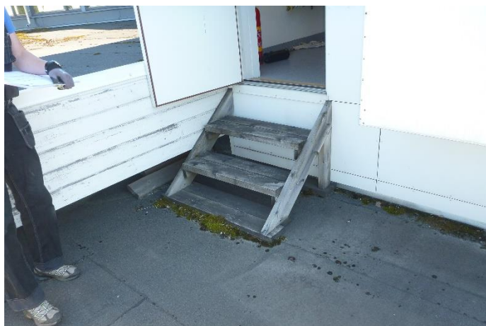
Trapp med CCA-trevirke
