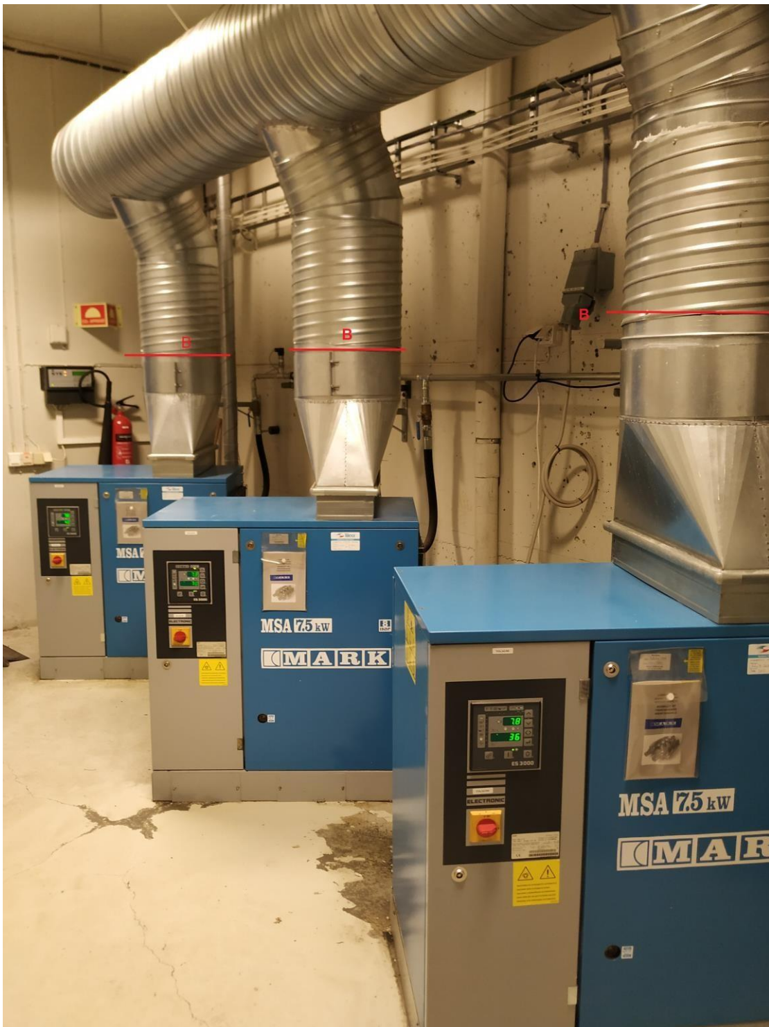
Figur 5 Bilde av eksisterende avkastarrangement med grensesnitt for kanalpåkobling
