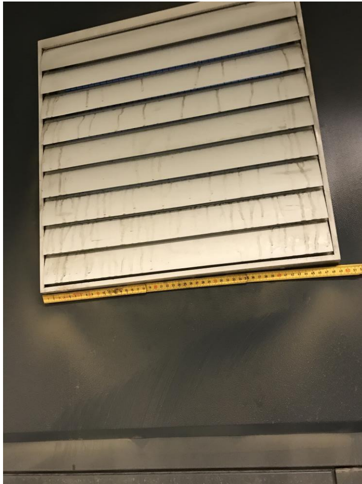
Figur 4 Bilde av eksisterende luftinntak med sjalusisjeld
