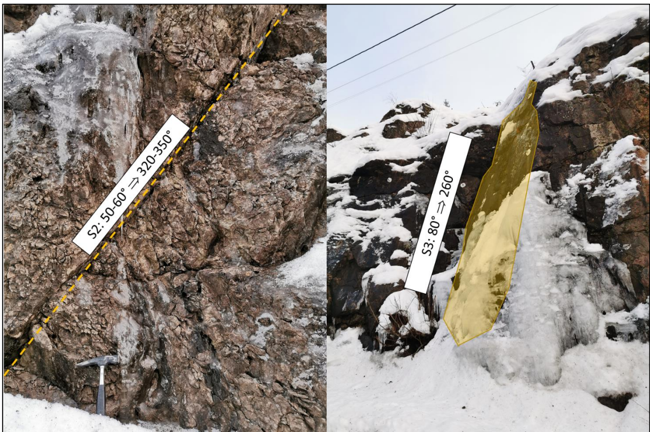
Figur 3-5: Illustrasjonsfoto av sprekkesett S2 (v.) og S3 (h.). Merk hvordan bergmassen er noe mer overflateforvitret og småfallen ved sprekkene tilhørende S2. Hammer for skala.
