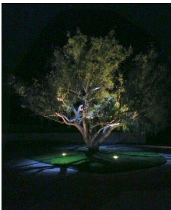
Eksempel på tre belyst fra nedfelte armaturer. For å oppnå god modellering er det viktig å benytte flere armaturer pr. tre. Dette også fordi trærne er synlige fra 360 graders vinkel.
