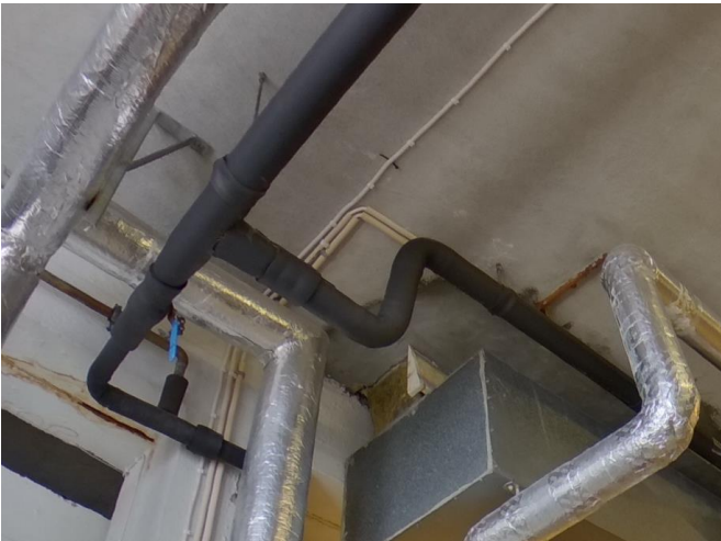
Bilde 7: Rør med cellegummiisolasjon.
