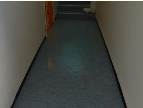
Bilde 14: Vinylgulv, typisk for store deler av bygget
