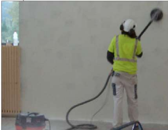
Figur 2: Pussemaskin påmontert støvavsug
