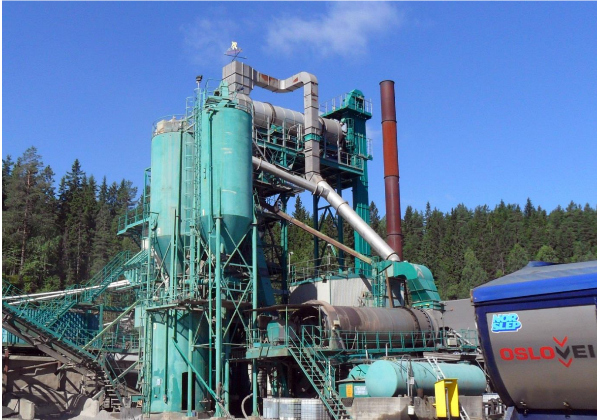
Bilde 9.3 Asfaltfabrikk med egen gjenbrukstrommel
