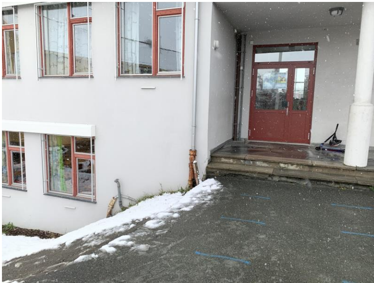
Oljetanken ser ut til å ligge under det grå bygget
