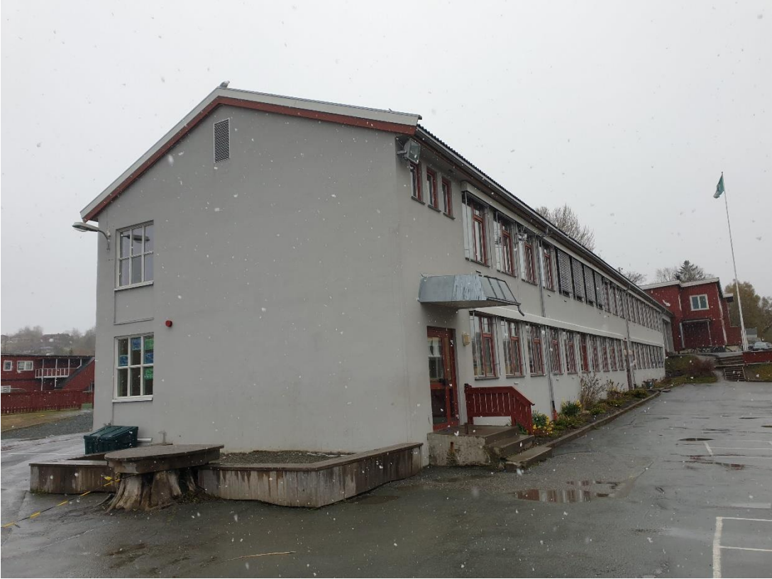
1956-bygg(skål dokumenteres før riving)
