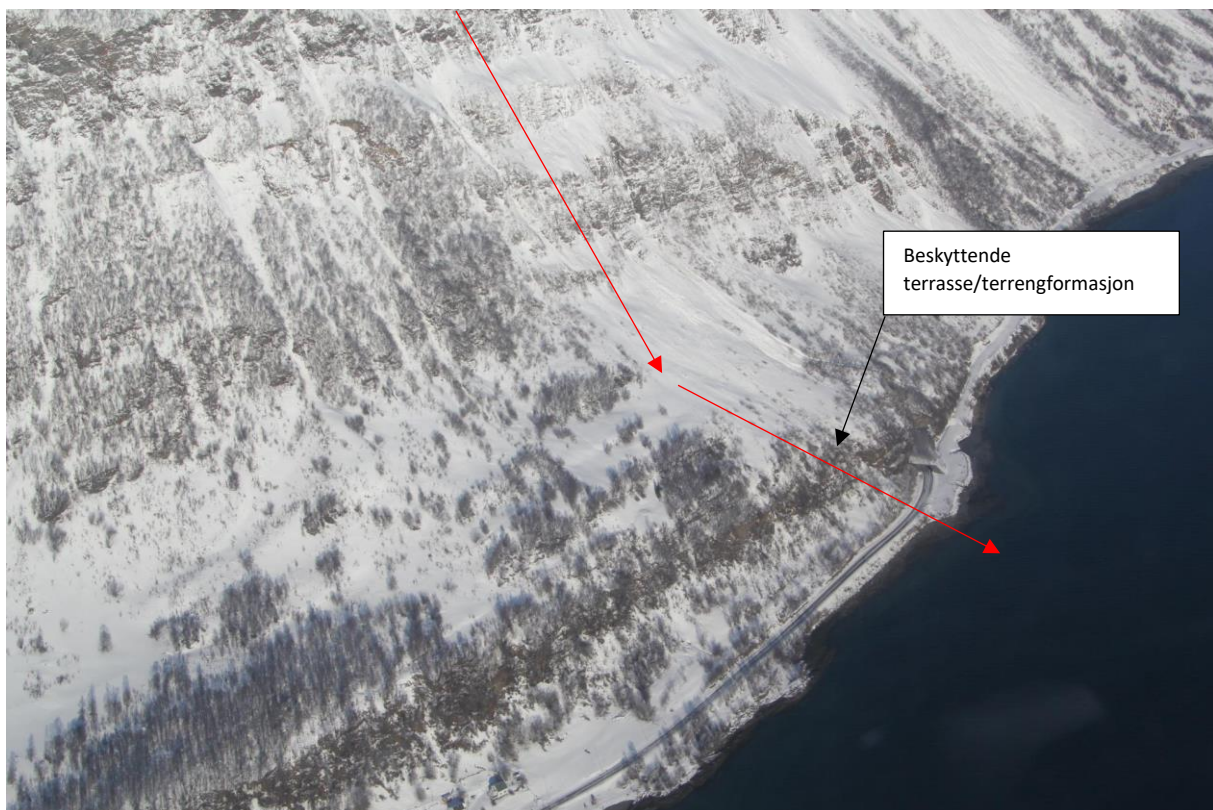
Figur 2: Viser omtrent hvor skredene treffer vegen. Det er sjeldent at det kommer noen store avsetninger av skred masser på selve vegen, men det skjer årlig at støvsken går over vegen.
