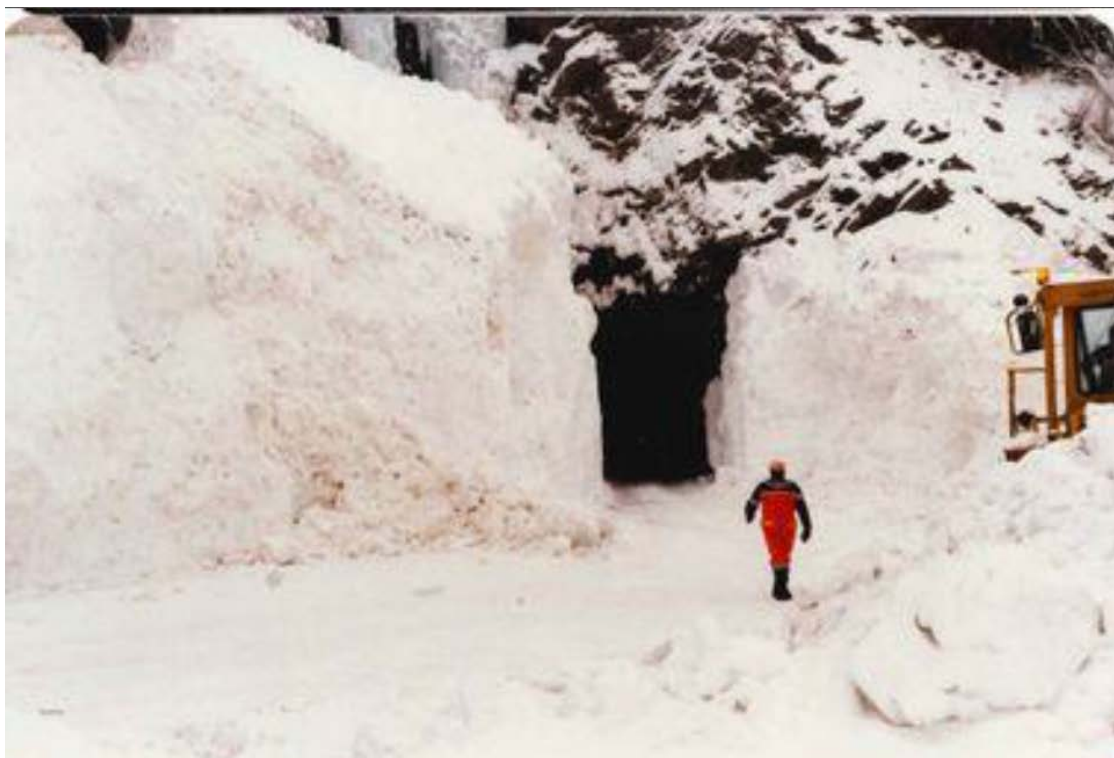
Figur 11 Eksempel på skredmasser som har stengt sørlige tunnel-portal. (Bilde fra SVV)
