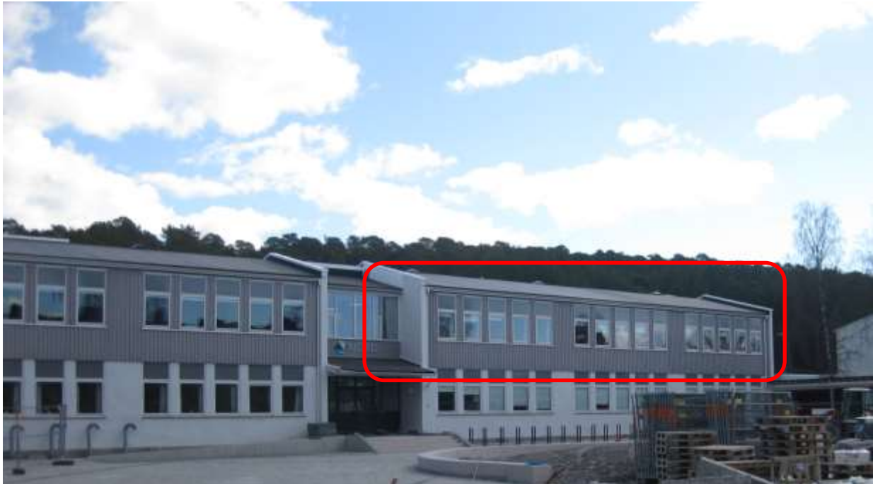
Figur 2-1. Bygg D, med aktuell fløy for ombygging til høyre.
