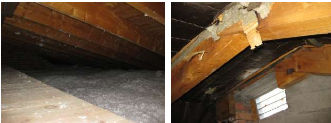
Figur 5-3 og 5-4: Kryploft. Mineralullisolasjon, treverk og blåseisolasjon.
