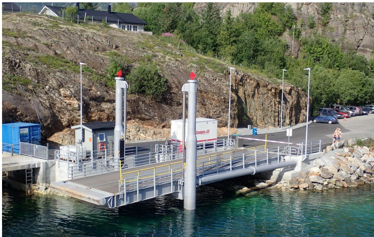
Jektvik ferjekai med ny bru 6x22 m
