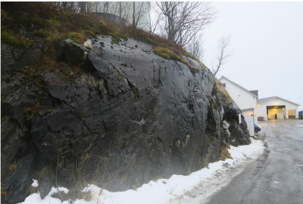
Foto 8. NV ende av eksisterende bergskjæring.
