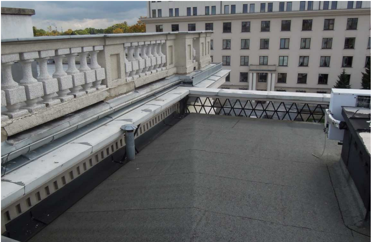
Widoczny styk dachu z budynkiem sąsiednim.
