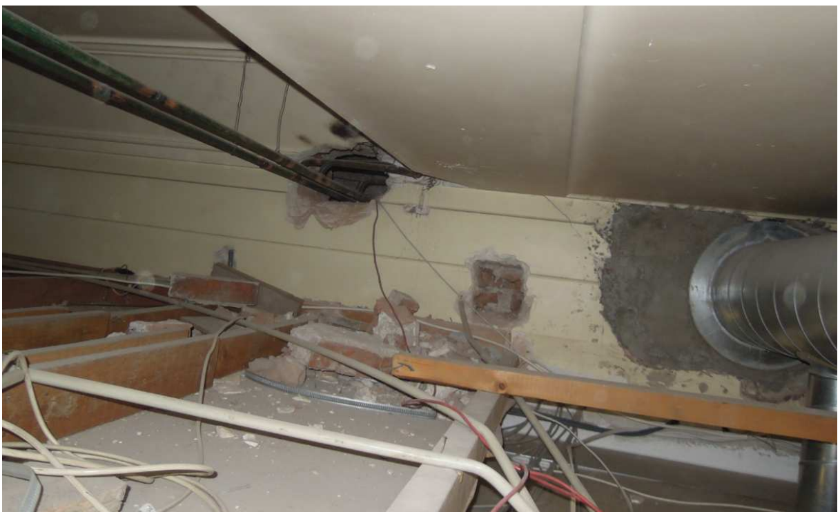
Widoczny sufit podwieszony i przebicia instalacyjne w poziomie parteru.
