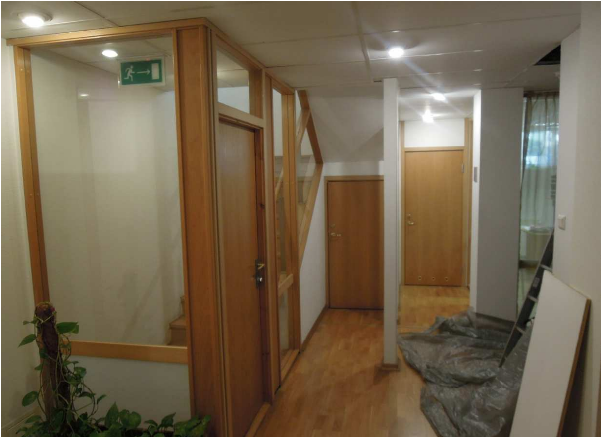
Widoczna klatka schodowa C wraz ze słupkami podpierającymi pasmo stropu.
