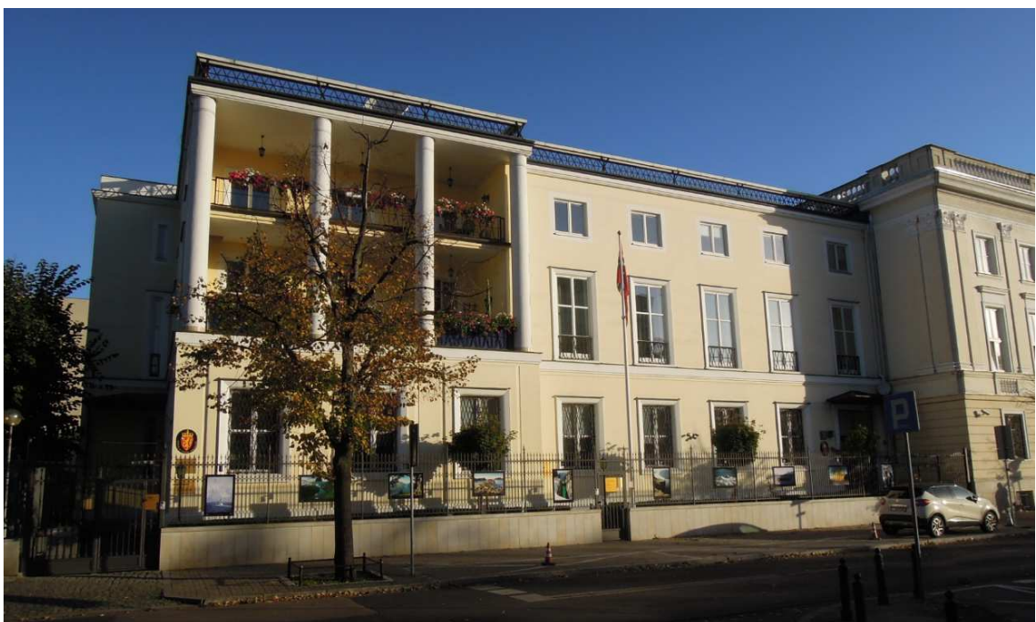
Widok obecny, elewacja frontowa budynku ambasady przy ul. Chopina 2A w Warszawie. 10.2017r.
