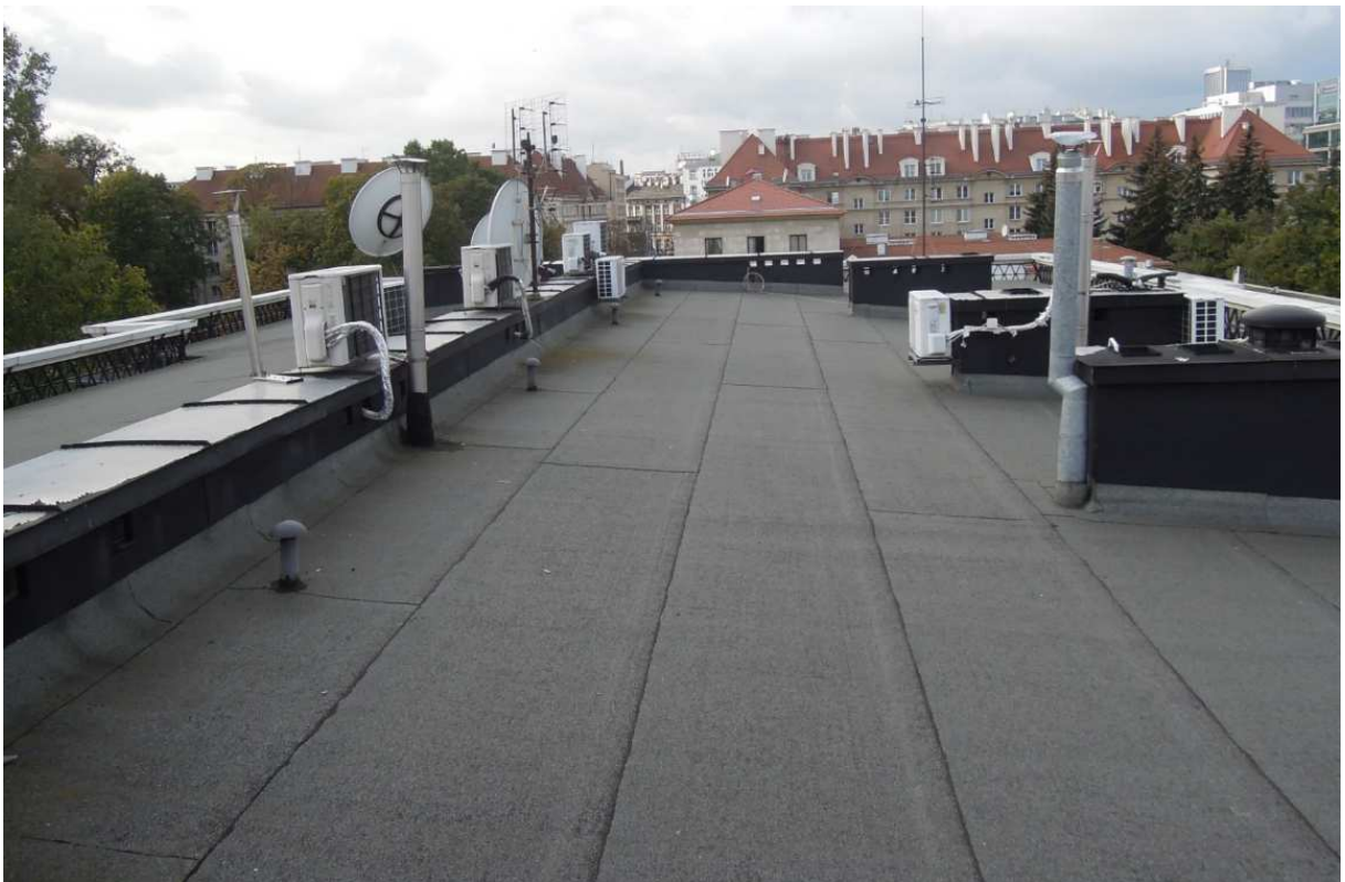
Widoczna połąć dachu z pokryciem z papy termozgrzewalnej.
