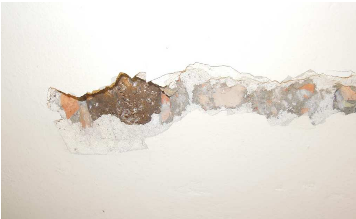
Widoczna dolna półka belki stropowej i płyta z betonu z kruszywem ceglanym, w odkrywce O.3.
