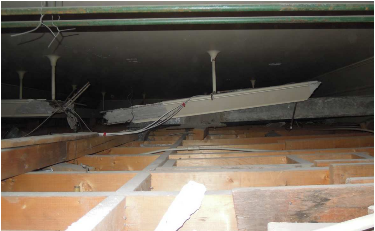
Widoczny sufit podwieszony i stare elementy wykończenia wnętrz w poziomie parteru.
