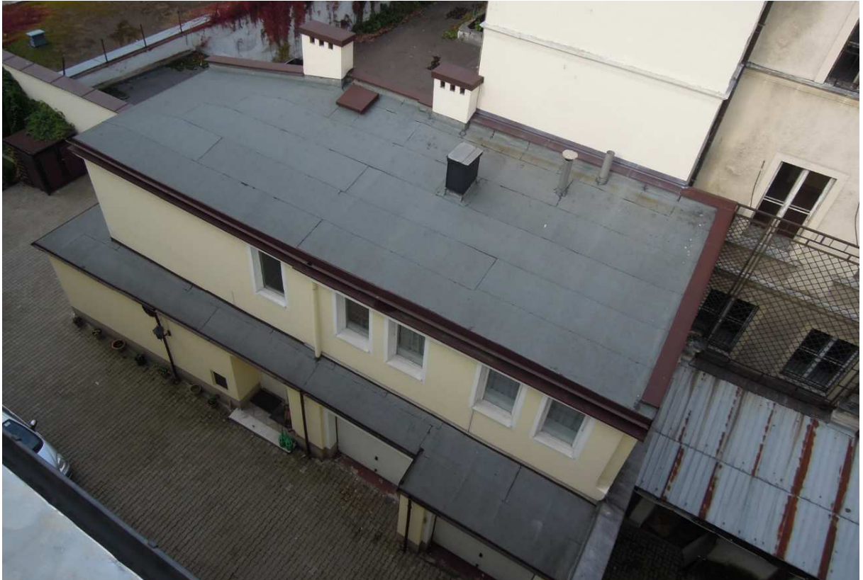
Widoczna połącz dachu z pokryciem z papy termozgrzewalnej. Widoczne wycofania elewacji piętra budynku względem ścian parteru.
