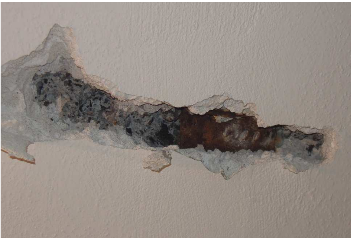
Widoczna odkrywka O.2 stropu z płytą żużłobetonową. Widoczna dolna półka belki stropowej.
