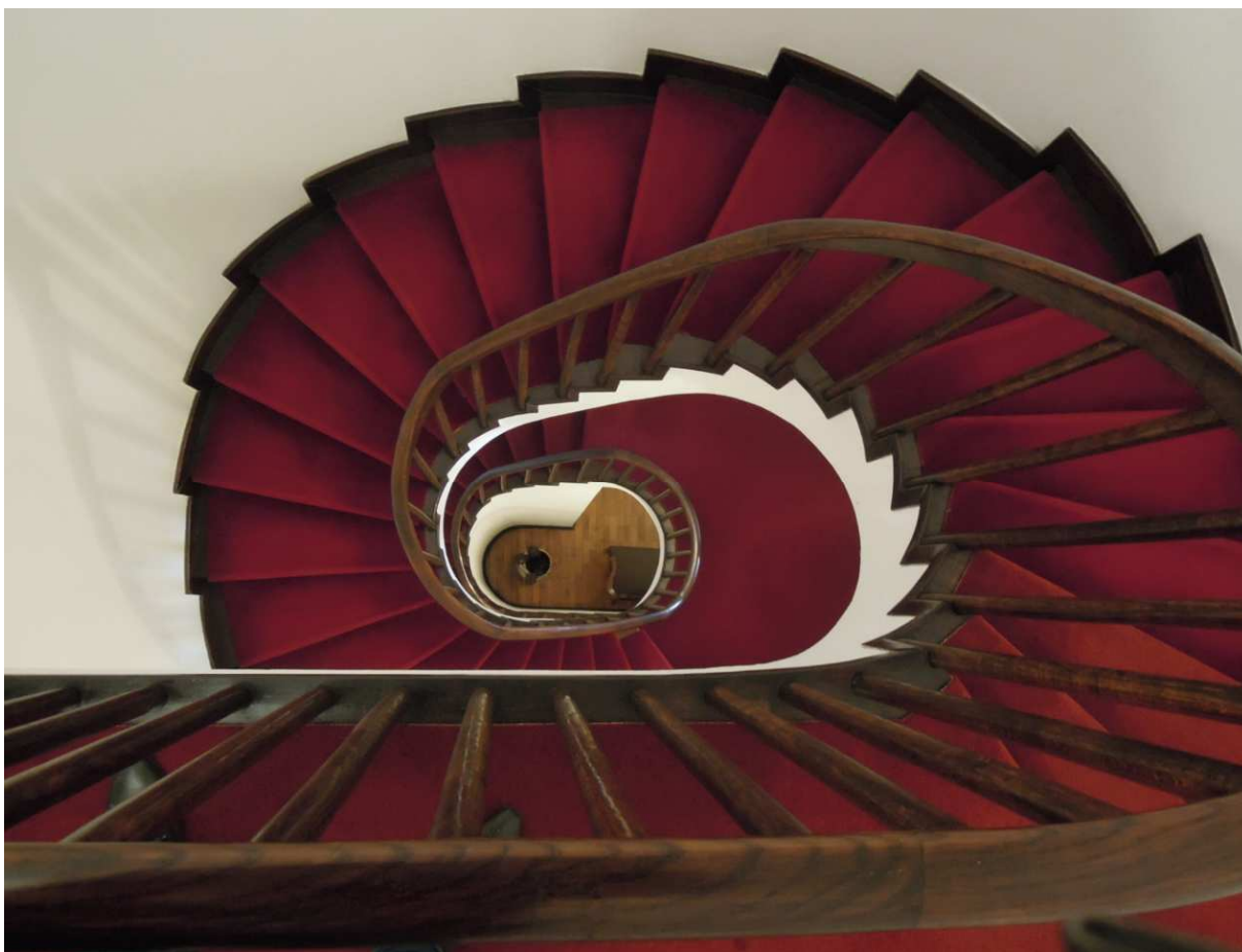
Klatka schodowa A, widoczne schody zabiegowe.
