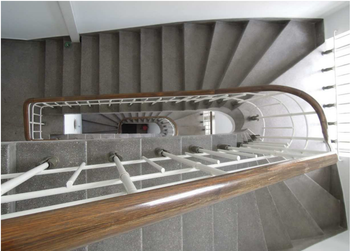
Klatka schodowa B, widoczne stopnie wykończone lastryko.
