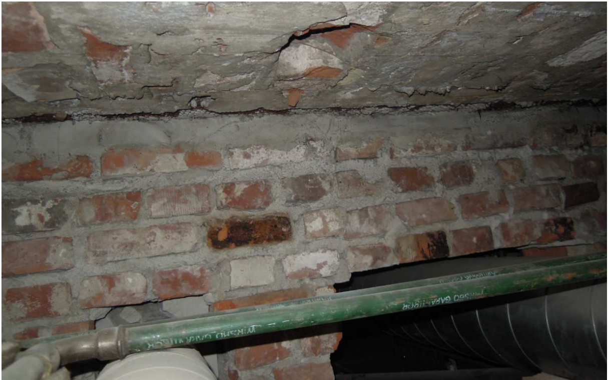
Widoczny płyty ceglane stropu Kleina i przebicia instalacyjne w poziomie parteru.
