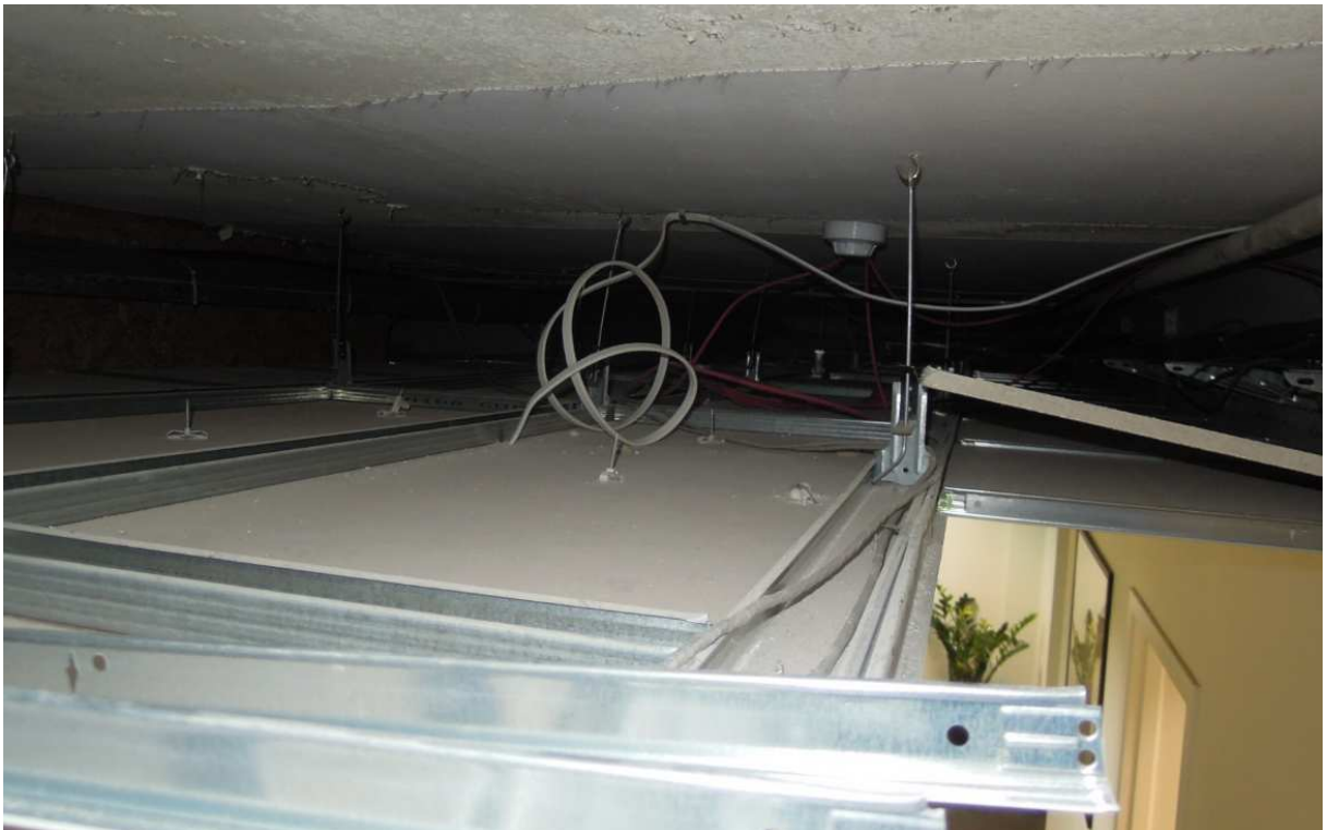
Widoczny sufit podwieszony w poziomie II piętra.
