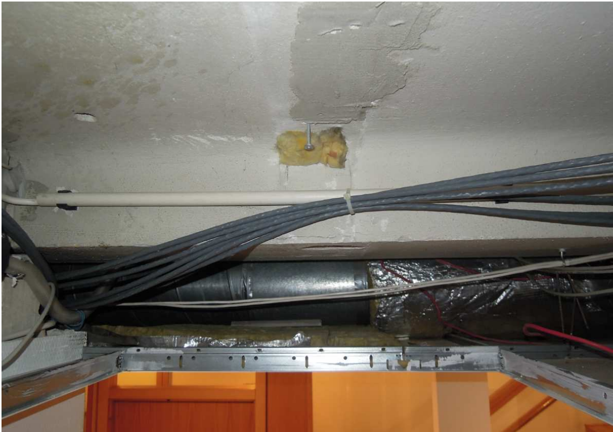
Widoczny podciąg w stropie nad piwnicą oraz instalacje ukryte sufitem podwieszonym.
