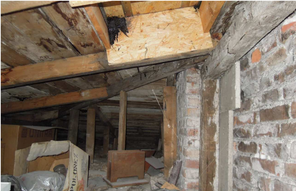
Widoczne częściowo wymienione elementy więźby dachowej.
