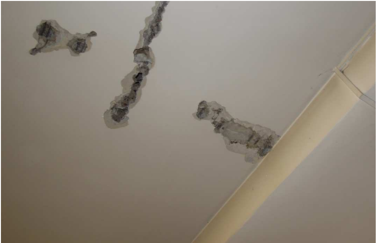
Widoczne belki żelbetowe stropu gęstożebrowego, w odkrywcę O.1.
