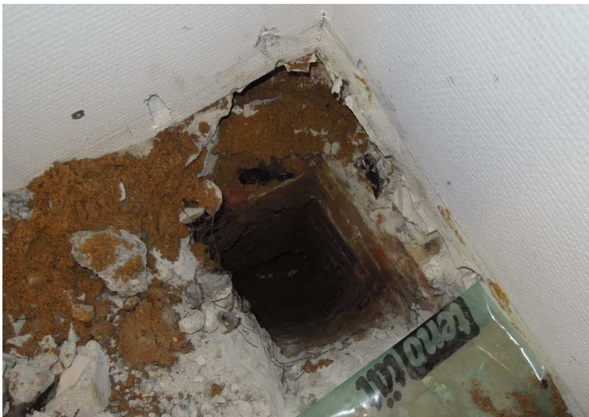
Odkrywka F.1 fundamentów. Widoczne ceglana ława i ściana.
