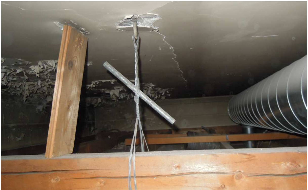
Widoczny sufit podwieszony i kanały wentylacyjne w poziomie parteru.
