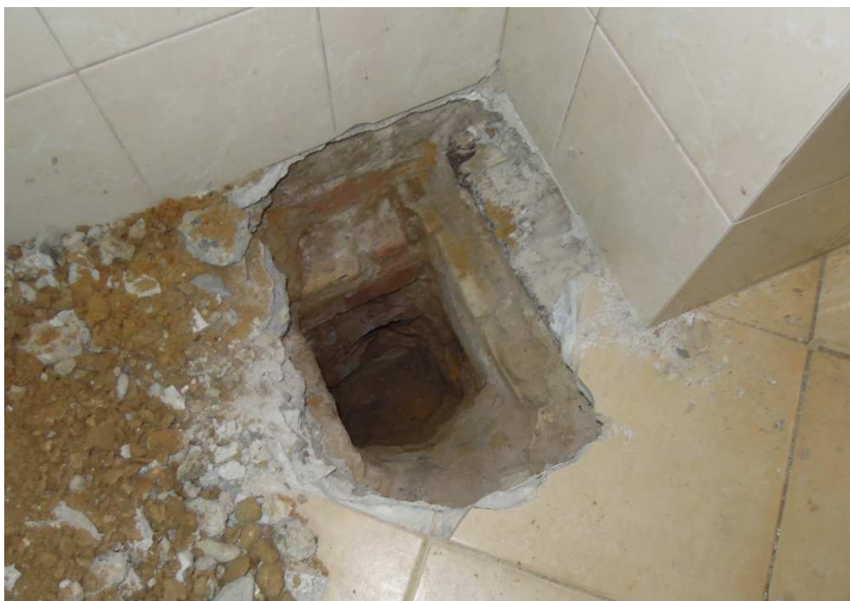
Odkrywka F.3 fundamentów. Widoczne ceglana ława i ściana.
