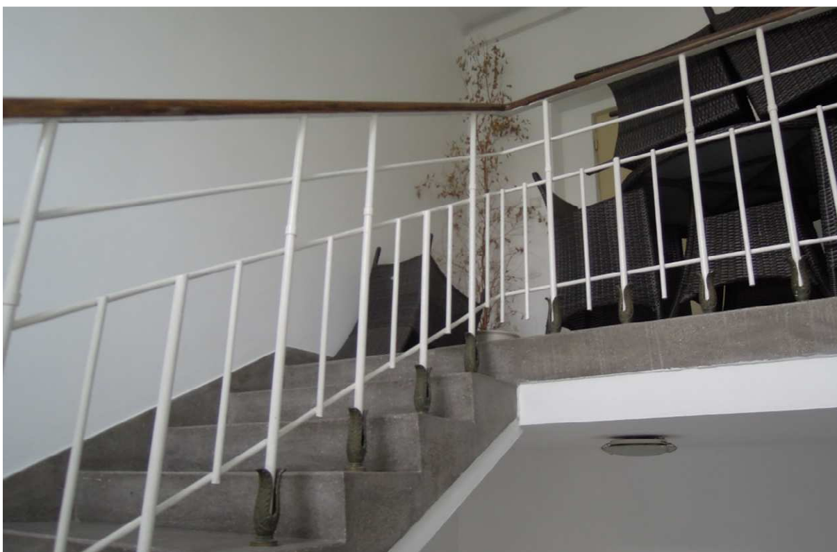
Klatka schodowa B, widoczne stopnie wykończone lastryko.
