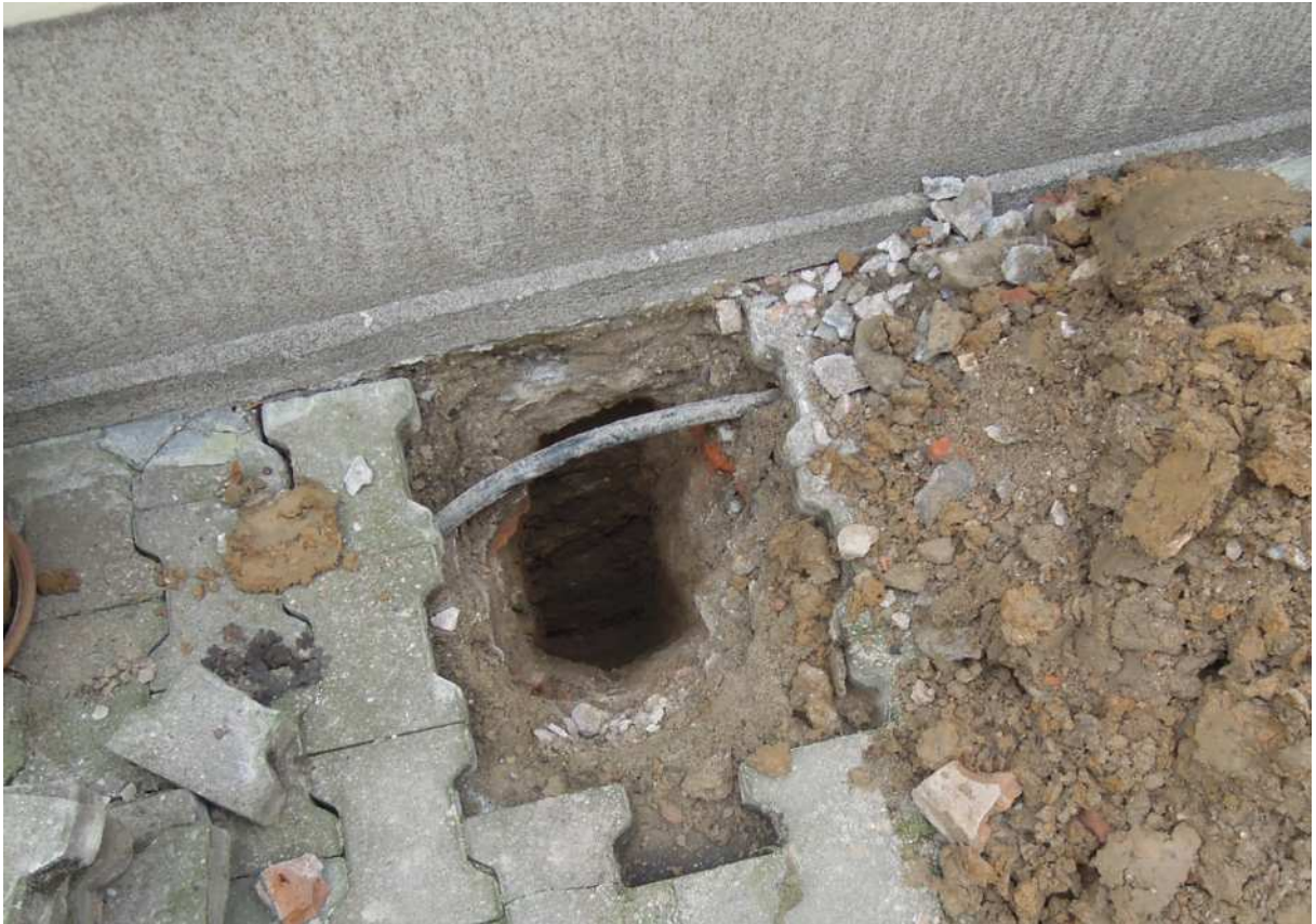
Odkrywka F.6 fundamentów. Widoczne ceglane ława i ściana.
