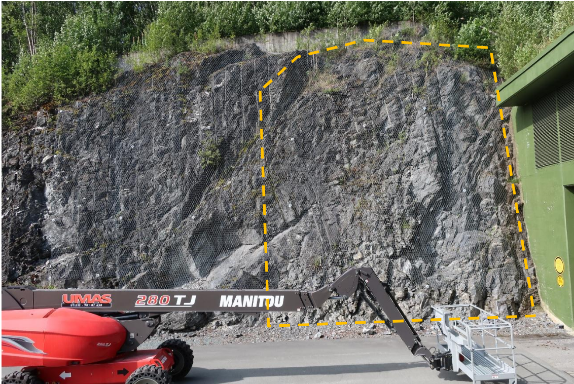
Figur 2: Område 2. Bergskjæring utenfor inngang øst. Tettere oppsprukket bergmasse er vist med stiplet strek.
