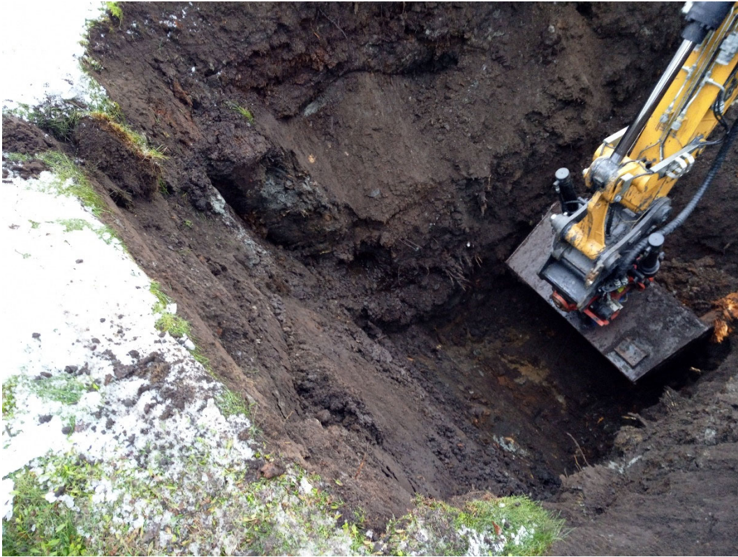
Bilde B5. Prøvegrop PG2. Graving ned til ca. 4m.
