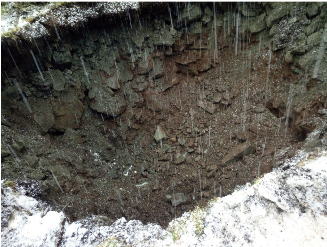
Bilde B8. Prøvegrop PG3. Graving ned til ca. 3m.
