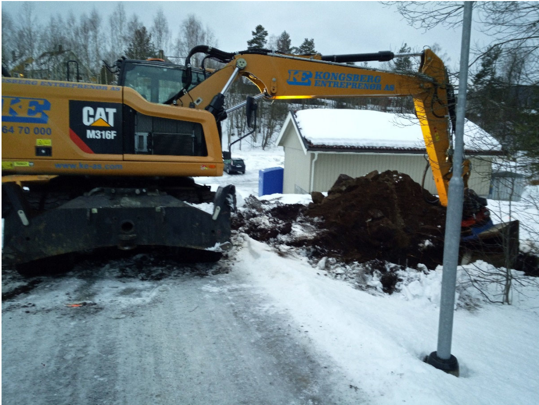
Bilde B1. 16 tonn gravemaskin av fabrikat CAT M316F brukt til arbeidene.
