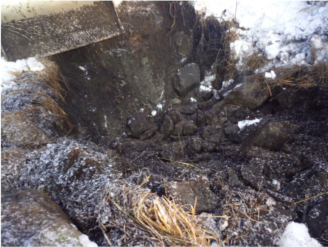
Bilde B13. Prøvegrop PG5. Berg påtruffet ca. 0,7m fra terreng.
