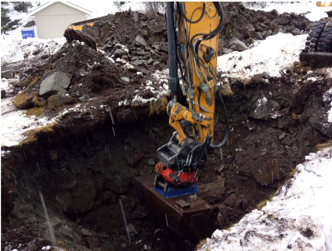
Bilde B7. Prøvegrop PG3. Graving ned til ca. 2m.
