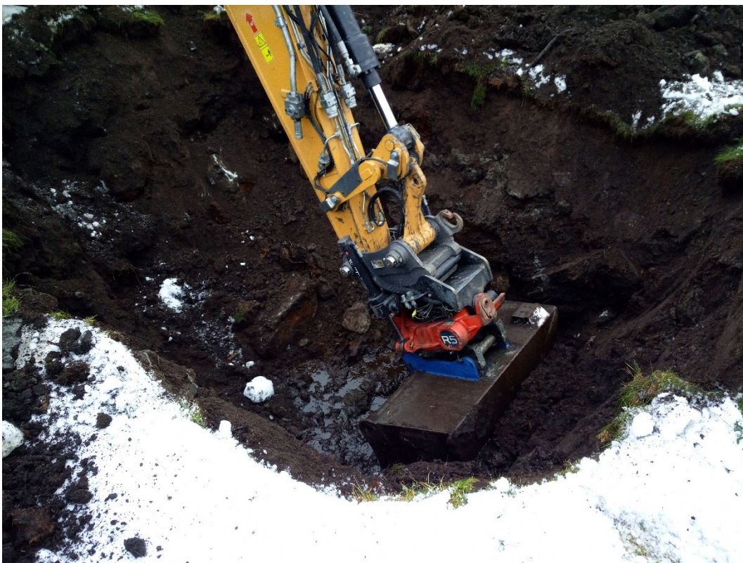
Bilde B4. Prøvegrop PG2. Graving av de første 2 meterne.
