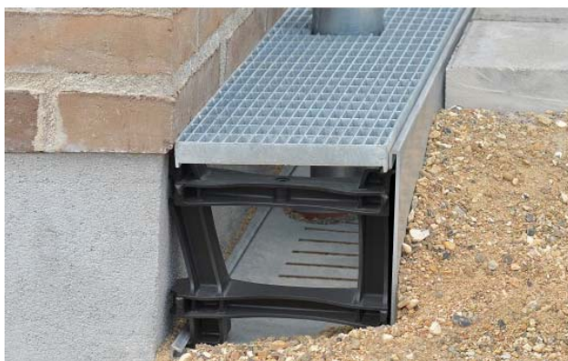
Sokkelrenne mot fasade
