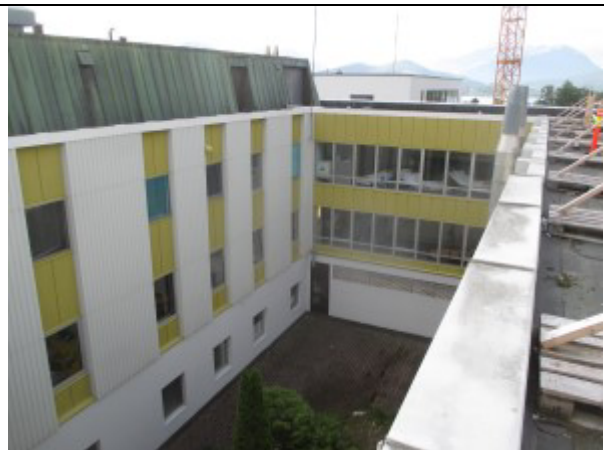
Bilde 5 Fasade som har internitplater bak metallplater (både mellom og over og under vinduer)
