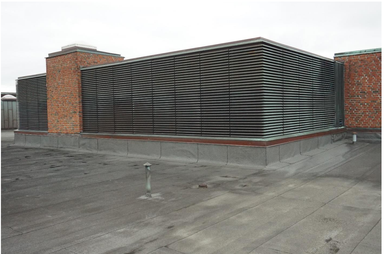
C fløy høy, ventilasjons-hus tak
